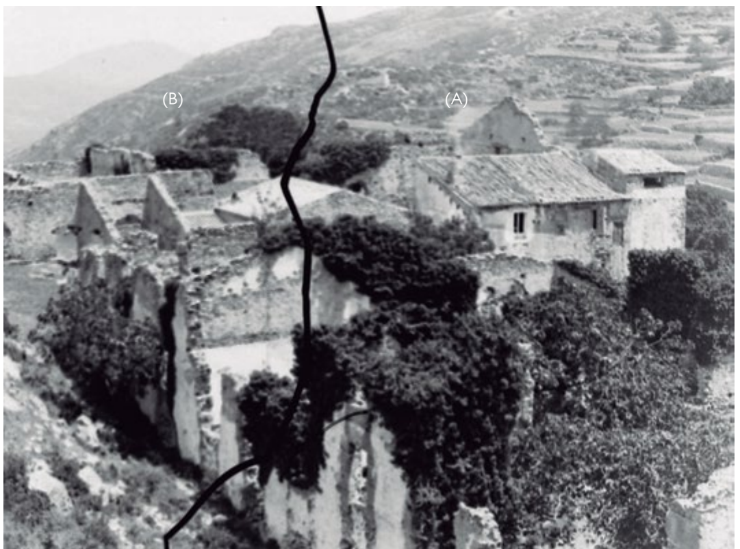
Fabrica de vidre a començament del segle XX. Un dels forns, parcialment visible, estava al pati del darrera de l'edificació de la dreta (A) i el segon al pati de l'esquerra (B)
