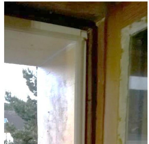
Abbildung 6: Blick von Innen durch das offene Fenster auf die Laibungsdämmung und die neue Dichtung.
