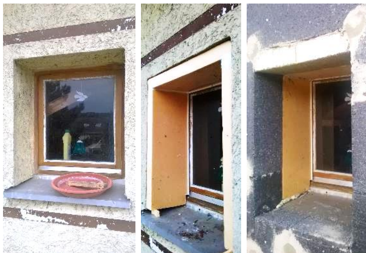
Abbildung 1: Links: Fenster vor der Maßnahme. Mitte: Mit Laibungsdämmung und mit (noch unverputztem) Wärmedämmverbundsystem (rechts).
