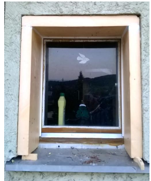
Abbildung 5: Laibungsdämmung eingeklebt
