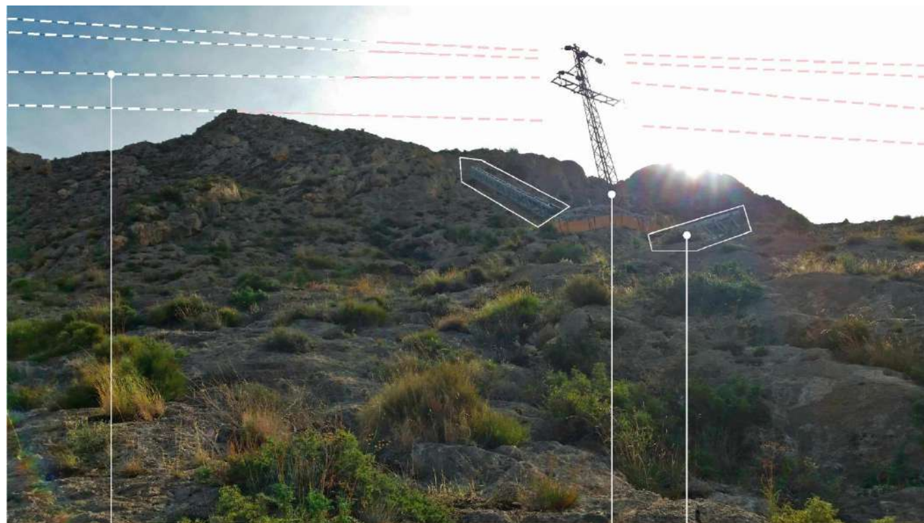
Tendido eléctrico aéreo
