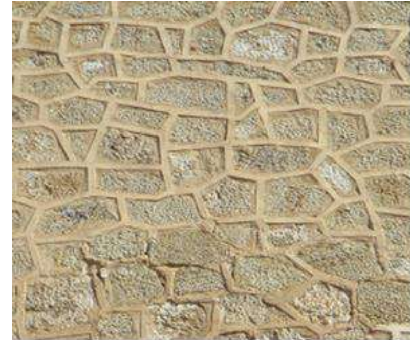
Imagen: Mampostería concertada, M7. Depósito de agua de los Pozos de Cremós C098. Fuente: Elaboracion Propia.
