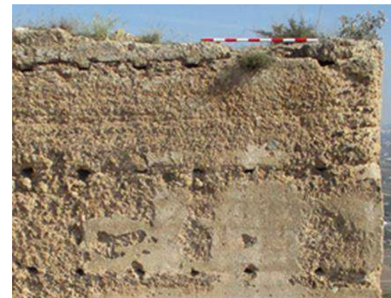
Imagen: Tabiya fina T3. Torre del albacar C017- Tabiya gruesa, T4. Torre Calle Torreta, C060. Fuente: Elab. Propia.
