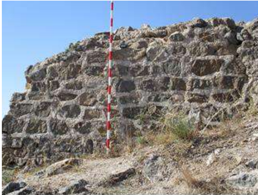
Imagen: Mampostería del lienzo Norte del albacar C020. Fuente: Elaboracion Propia.
