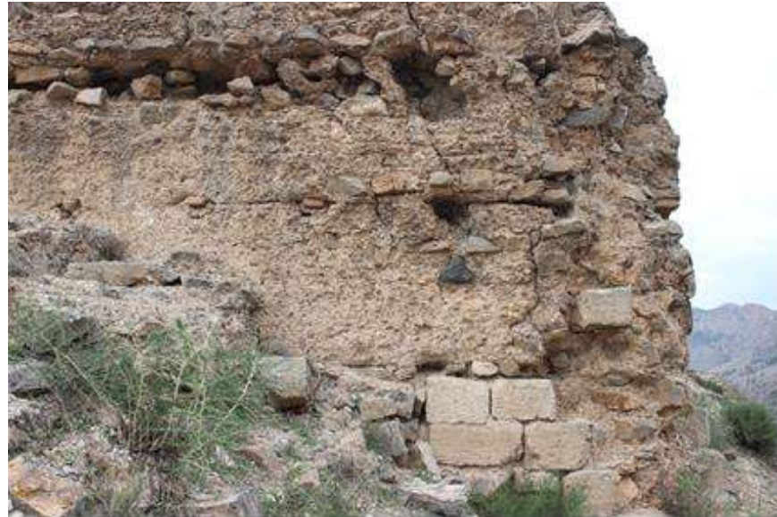
Imagen: Torre NW. de la alcazaba C005. Tapial con encadenado de sillería T4/S3. Fuente: Elab. Propia.
