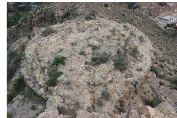
Imagen: Núcleo de cal y canto de la torre circular del albacar- Interior de la base de un berje-contrafuerte en el lienzo W. del albacar C013. Fuente: Elaboración Propia.
