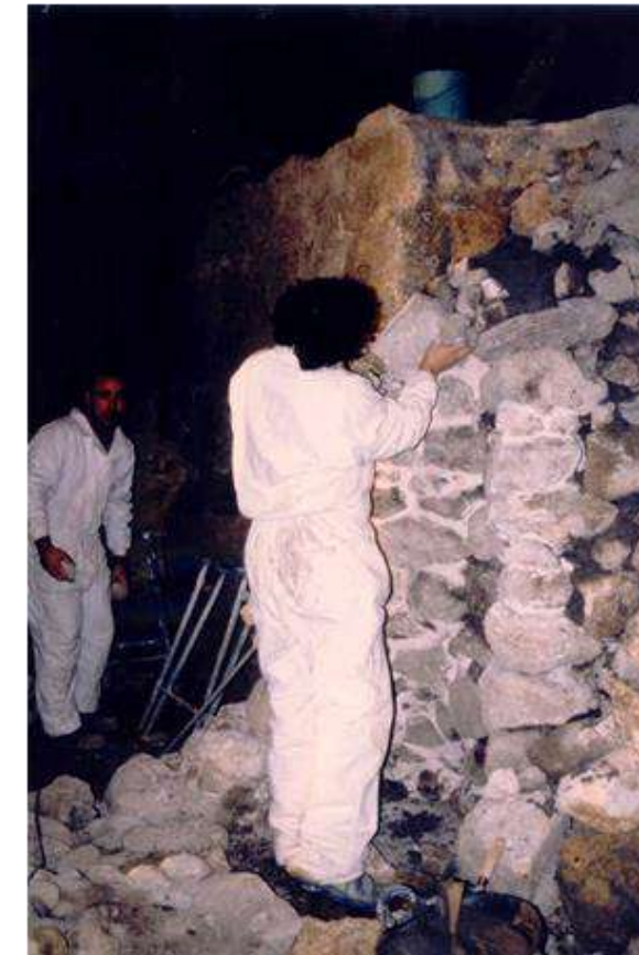
Imagen: Consolidación el pozo adosado a la muralla. Fuente: Elaboración Propia.
