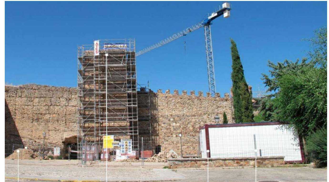
Materiales de construcción Presencia de grúas y andamios Presencia de casetas de obra Vallados provisionales
