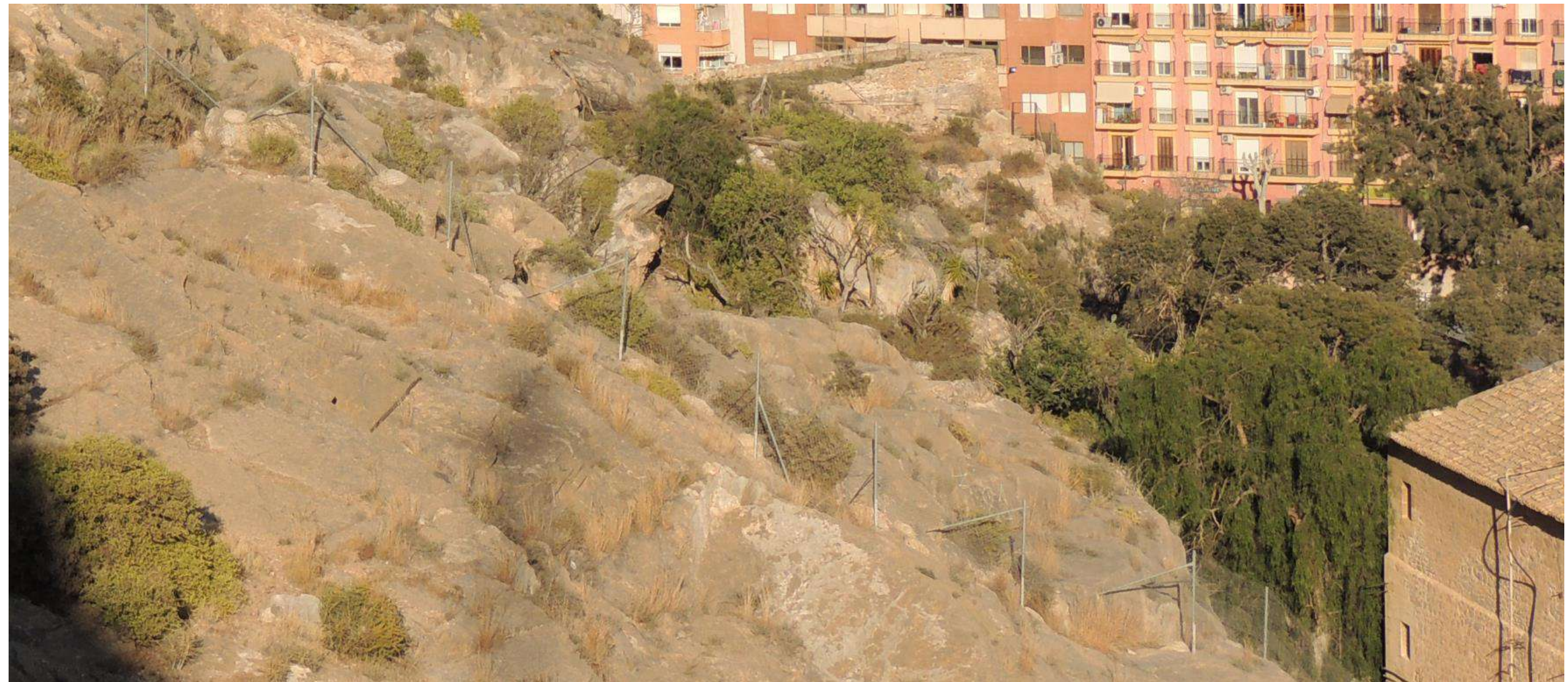
Vallado sobre el monte público municipal en el entorno del Colegio Santo Domingo que impide el acceso público a la "Batería del Palomaret" (elemento 126) en el centro superior de la imagen.
