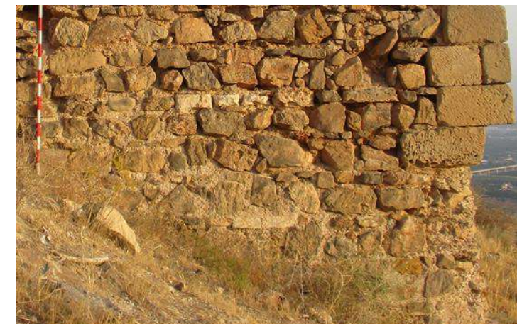
Imagen: Torre del albacar C015 .Mampostería con encadenado de sillería M4/S2. Fuente: Elabor. Propia.
