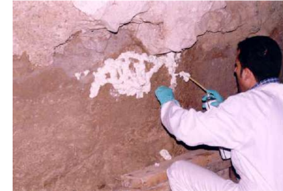
Imagen: Consolidación de uno de los muros de tapial de las viviendas islámicas.
