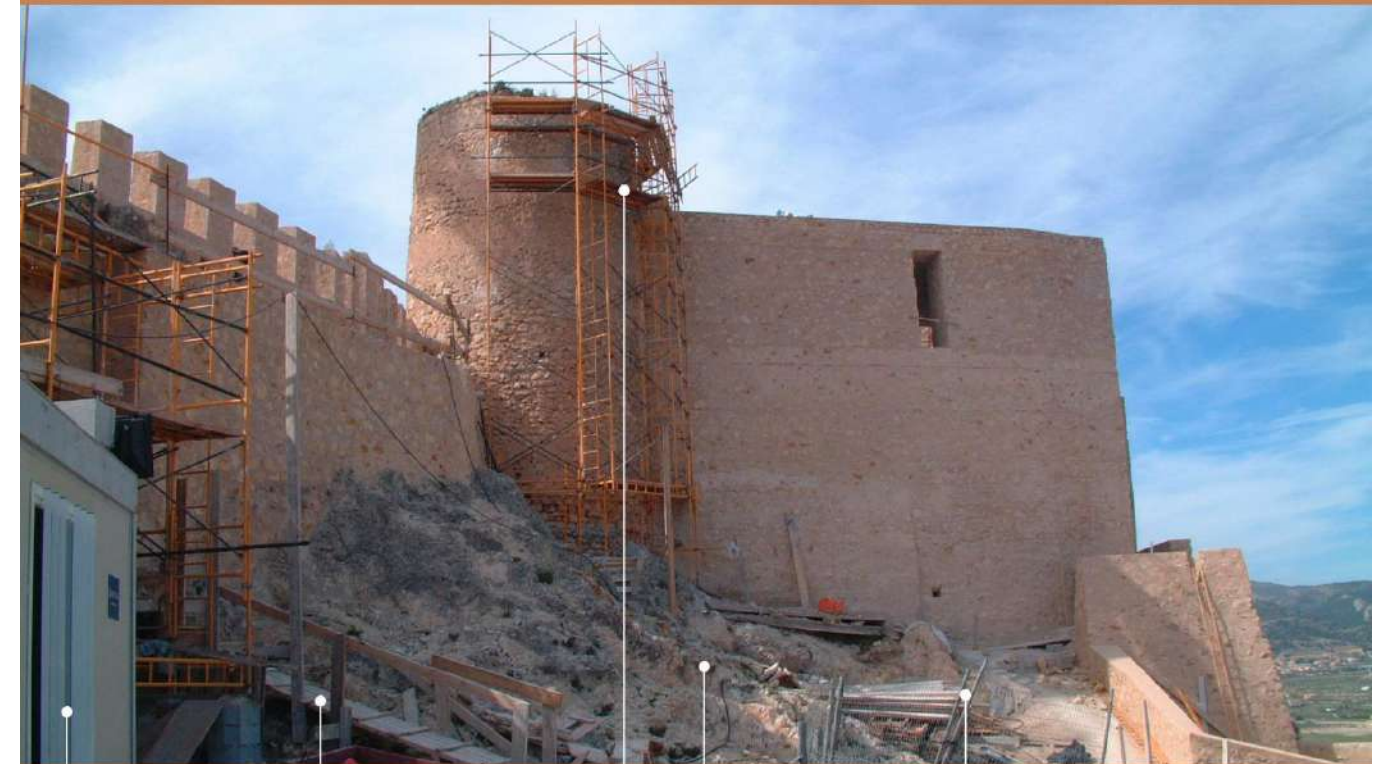
Presencia de casetas de obra Apertura de accesos Presencia de andamios Generación de polvo Materiales de construcción
