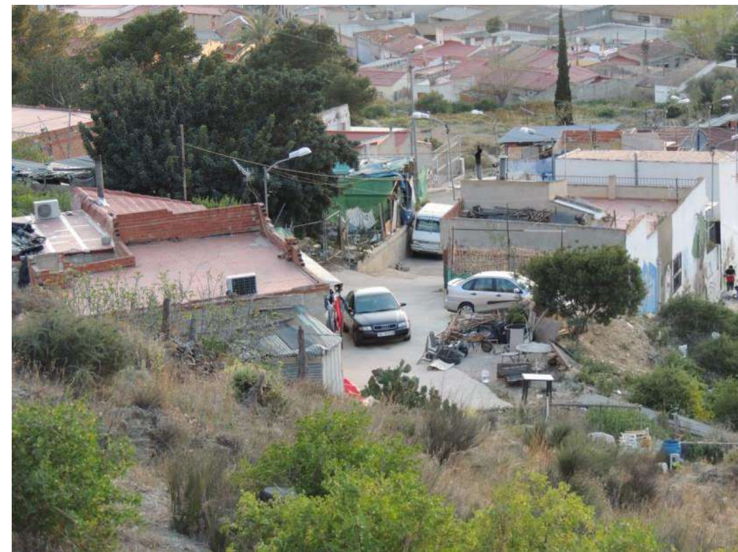
Invasión vereda sobre M.U.P. nº5 al Oeste junto al Barrio San Isidro – Fuente: Instituto Cartográfico Valenciano
