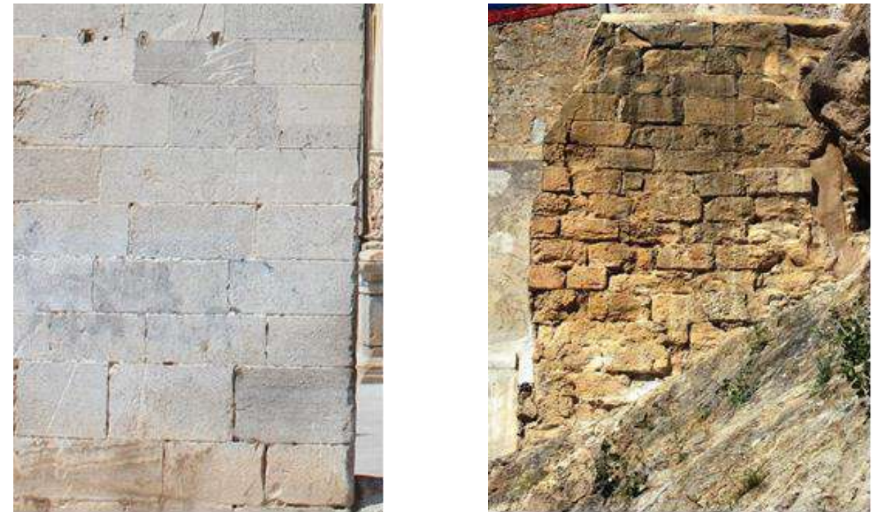
Imagen: A la izquierda, detalle de la sillería de caliza dolomítica de la puerta de Callosa C077. A la derecha, sillería de arenisca del lienzo situado junto a la Puerta de Crevillente C075. Fuente: Elaboracion Propia.
