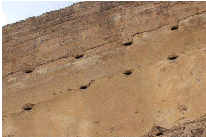
Imagen: Lienzo de supuesta cronología taifal en tapial calicostrado C036, realizado con los cajones dispuestos según la pendiente del terreno. Fuente: Elaboración Propia.
