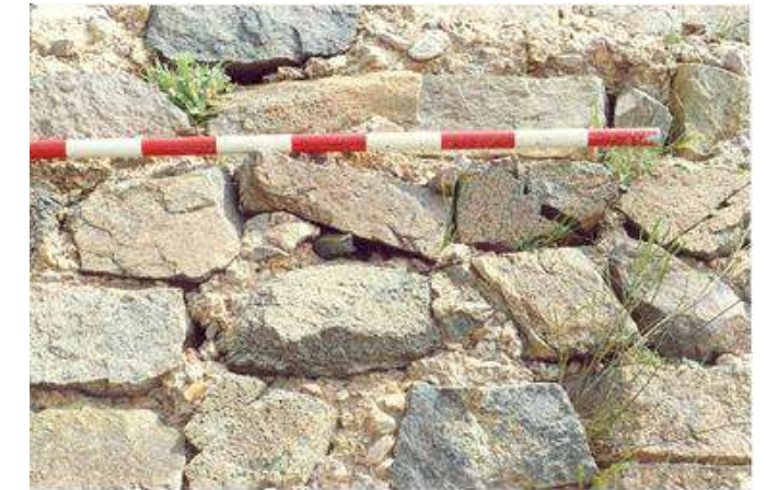
Imagen: Mampostería en hiladas horizontales de caliza dolomítica, muro W. del albacar C013-- Mampostería en hiladas horizontales de piedra metabasita, Castillo del Oriolet, C078. Fuente: Elaboracion Propia.
