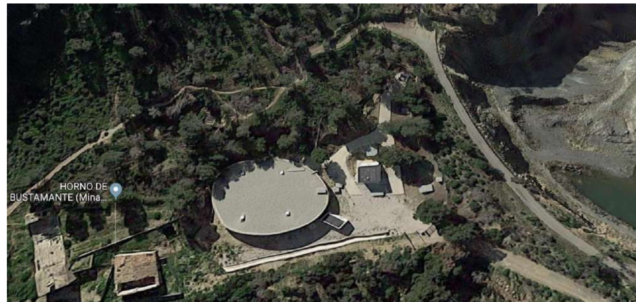
Ortoimagen de las infraestructuras de la MCT en el MUP nº 5 “La Sierra” – Fuente: Google Maps
