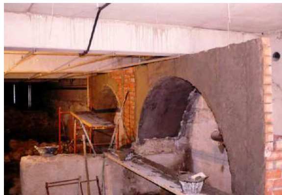
Imagen: Proceso de construcción de la restitución volumétrica parcial de las bóvedas de los baños árabes. Fuente: Elaboración propia.
