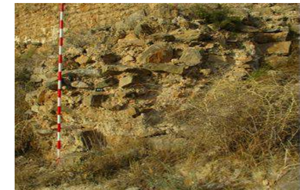
Imagen: Núcleo de cal y canto de la torre circular del albacar- Interior de la base de un berje-contrafuerte en el lienzo W. del albacar C013. Fuente: Elaboración Propia.
