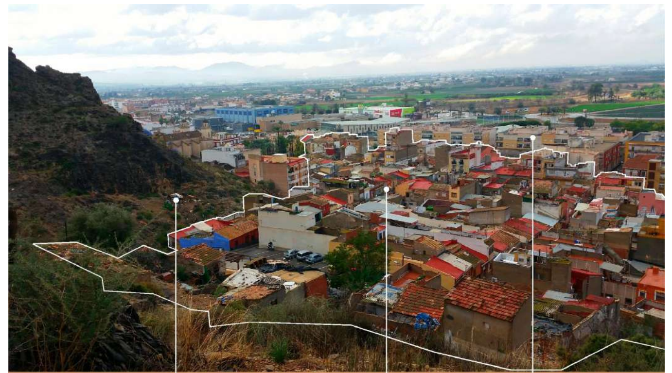
Cobertizos y depósitos de enseres Vivienda-ruina Infravivienda Zona Rabaloché
