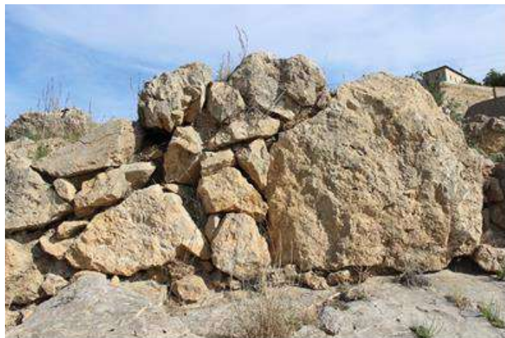
Imagen: Aparejo ciclópeo de uno de los muros del recinto de San Miguel C045. Fuente: Elaboracion Propia.
