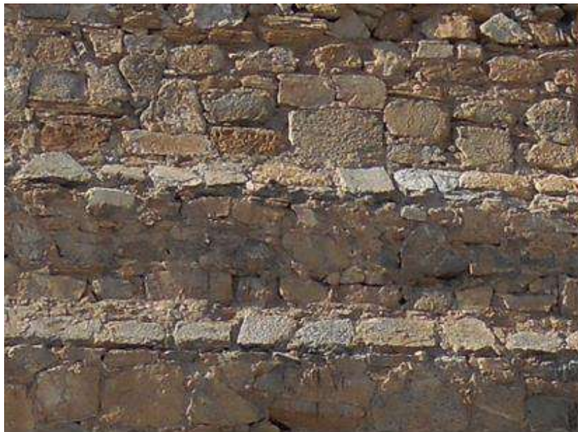
Imagen: Mampostería careada con algunos sillarejos. Baluarte de San Miguel C092. Fuente: Elaboracion Propia.
