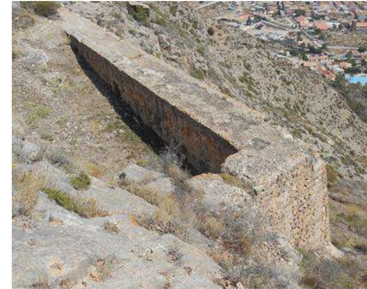
Imagen: Presa de gravedad (C025). Fuente: Elaboración Propia.
