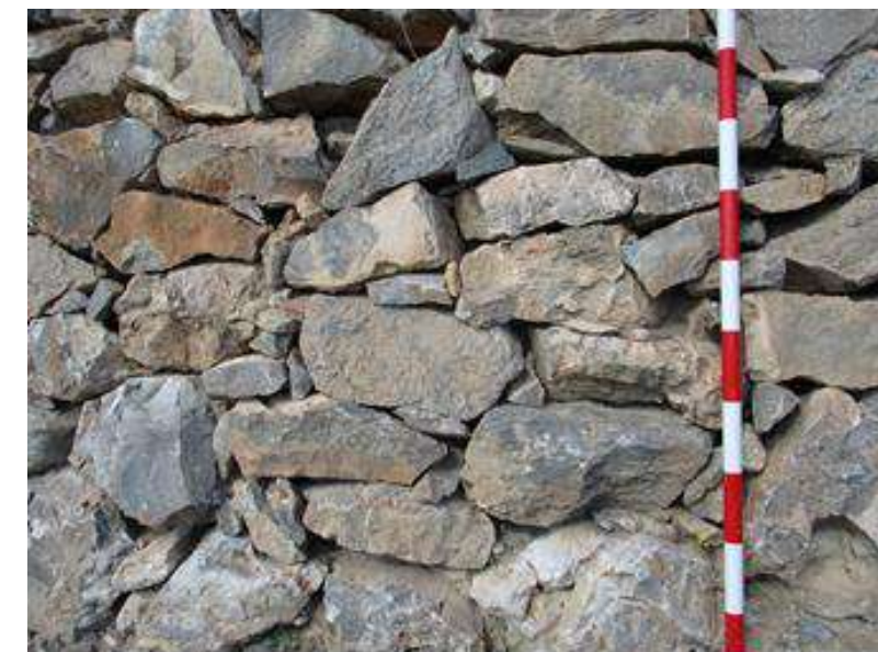
Imagen: Mampostería de uno de los bancales de cultivo situados bajo el seminario C125. Fuente: Elaboracion Propia.
