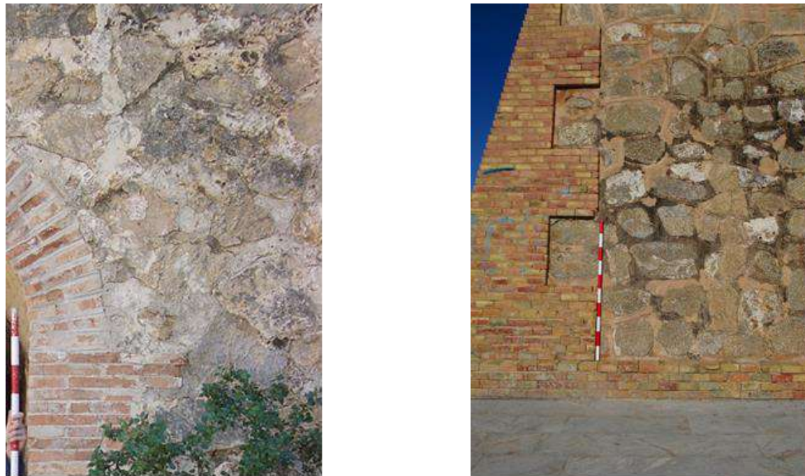
Imagen: Técnicas mixtas de mampostería y ladrillo. A la izquierda "Horno Santa Matilde, elemento del catálogo C101, técnica mixta M2/L1 y a la derecha Pozos de Cremós, C098, M6/L1. Fuente: Elab. Propia.
