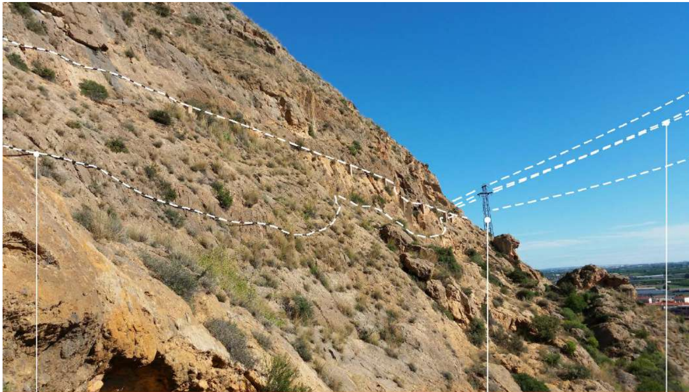
Tuberías de abastecimiento de agua potable al Seminario Torre eléctrica Tendido eléctrico aéreo
