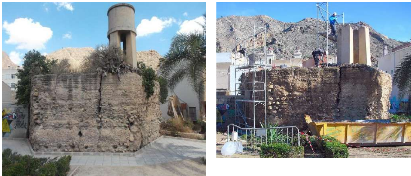
Imagen: vista del Depósito y su desmontado. Fuente: Elab. Propia.
