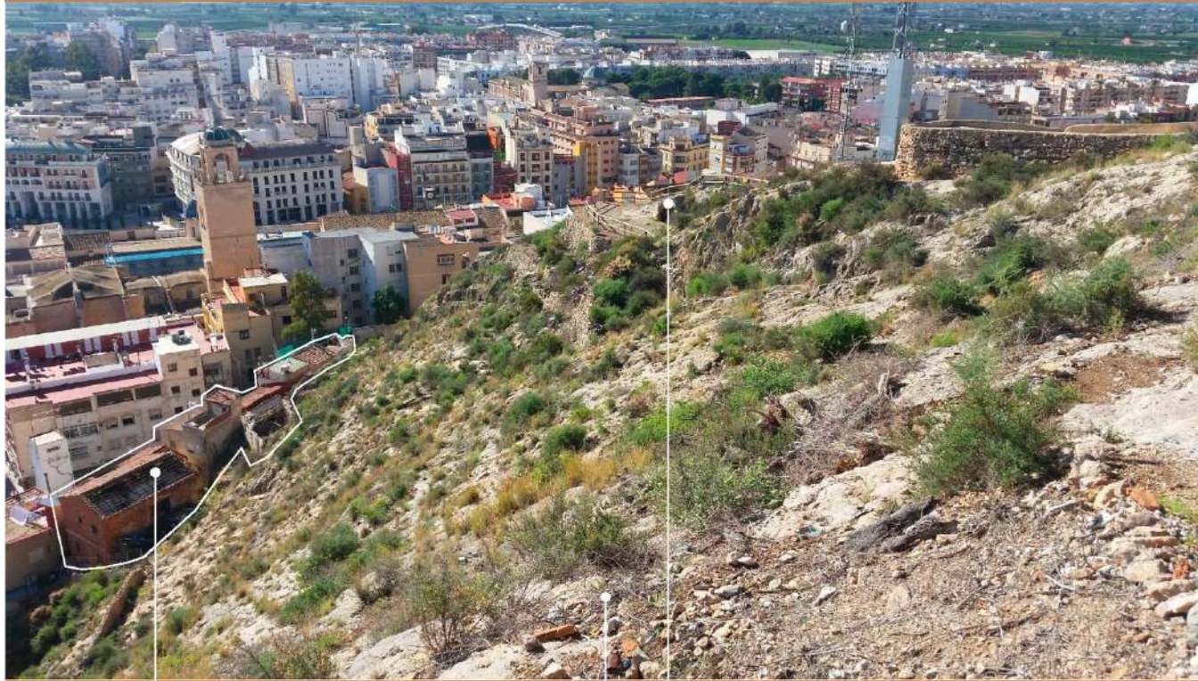
Infraviviendas Residuos de construcción Mirador en estado deficiente
