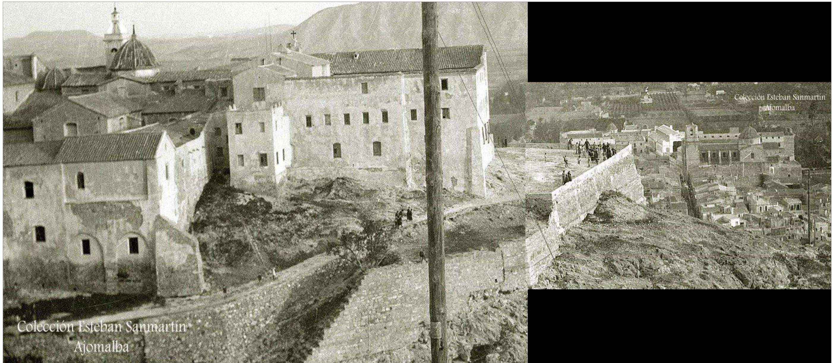
Primera mitad Siglo XX: Cara noroeste del edificio del Seminario antes de la ampliación hoy existente. Se muestra el frente y flanco derecho del Baluarte de San Miguel, donde se aprecia con detalle la escalera existente en dicho momento –hoy ocultada tras su ampliación, en su cota superior, para paso de vehículos-, que bajaba hacia el barranco para continuar, por el frente de la Cortina del Olivar y mediante escalonado del monte, hacia el Flanco del Descubridor.
