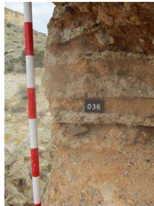
Imagen: A la izquierda tapial calicostrado, torre superior en las proximidades de la calle Torreta C059. A la derecha tapial de la torre de cronología taifal C036. En ambos casos con líneas de mechinales y cajones dispuestos horizontalmente, T2. Fuente: Elaboración Propia.
