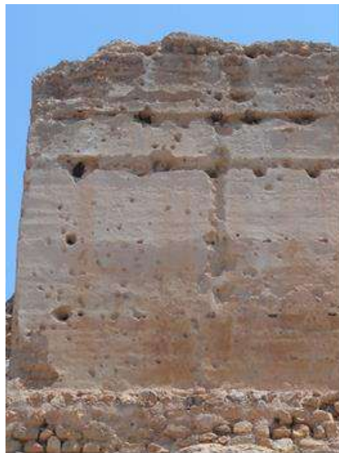
Imagen: A la izquierda tapial calicostrado, torre superior en las proximidades de la calle Torreta C059. A la derecha tapial de la torre de cronología taifal C036. En ambos casos con líneas de mechinales y cajones dispuestos horizontalmente, T2. Fuente: Elaboración Propia.
