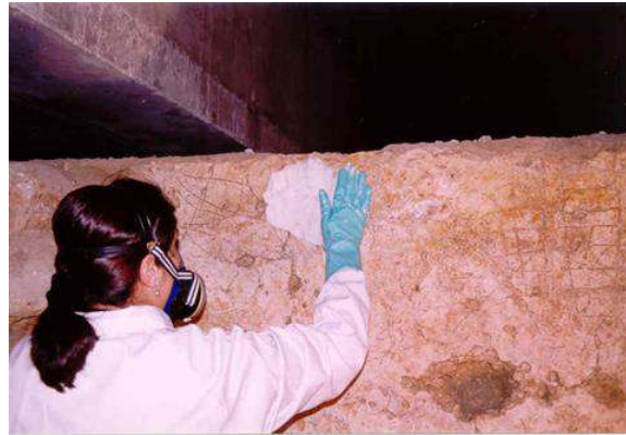
Imagen: Trabajos de limpieza del interior de una torre que prentaba graffitis. Fuente: Elaboración propia.
