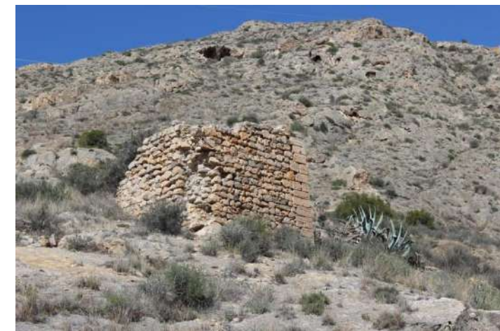
Imagen: Torre de mampostería con encadenado de sillería en las esquinas (C041), obra del siglo XIV. Fuente: Elab. Prop.
