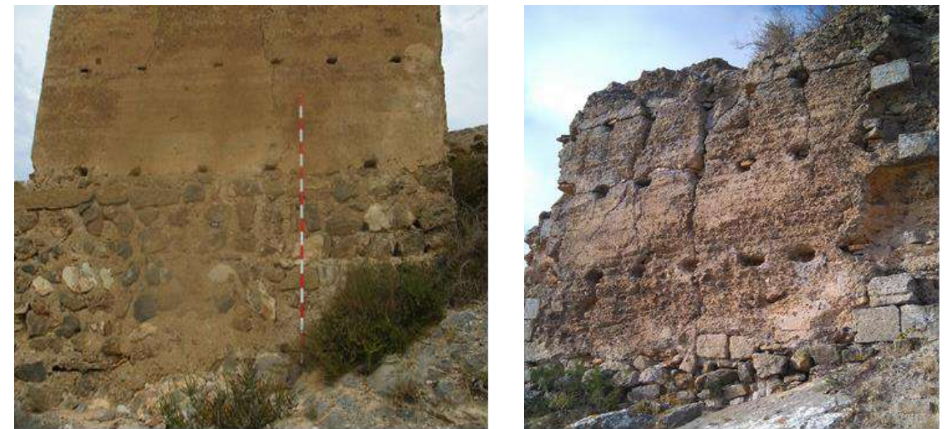
Imagen: Torre de cronología taifal C036. Obra mixta con zócalo de mampostería y alzado de tapial calicostrado M2-3/T2- Torre de la alcazaba C005. Zócalo de mampostería y tabiya, con encadenado de sillería y ladrillo en los mechinales. M3/T4/S3/L1. Fuente: Elaboracion Propia.
