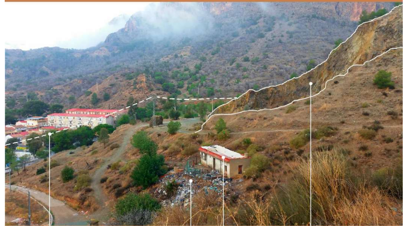
Línea eléctrica aérea Vertidos Infravivienda Cantera abandonada
