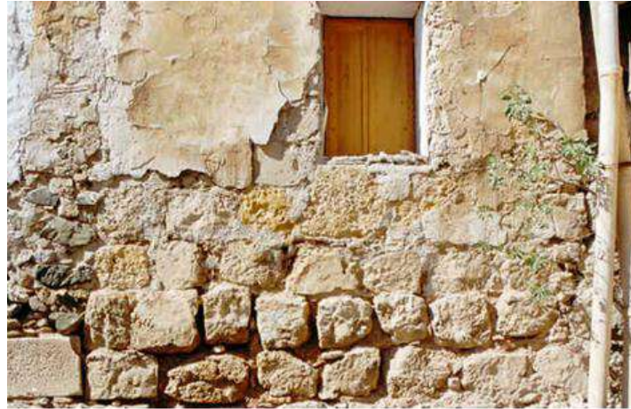
Imagen: Obra de sillarejos sobre el cajero de la acequia de Almoradí, C069. Fuente: Elaboracion Propia.
