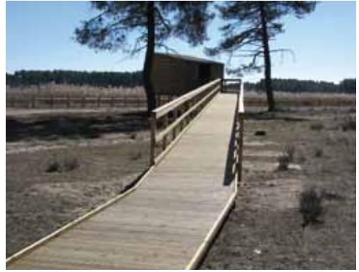
Rampa de acceso al observatorio accesible en la laguna de Navahornos.
