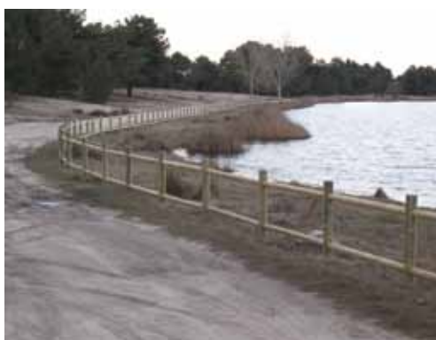
...y se han sustituido por casi dos kilómetros de talanqueras de madera.
