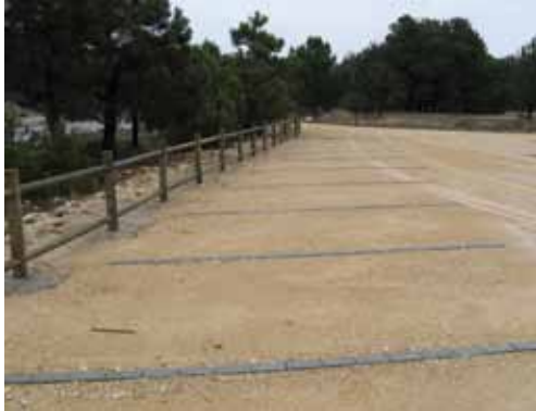
Aparcamiento de Navalayegua, situado junto al camino asfaltado de Cantalejo a Lastras de Cuéllar.
