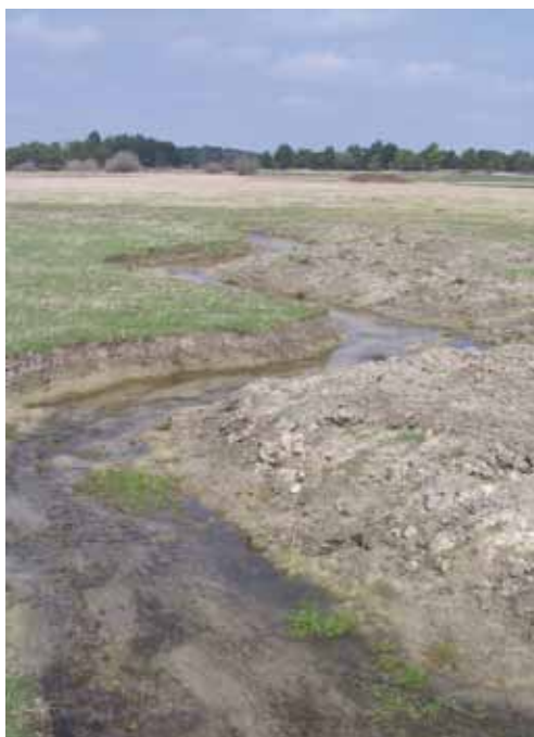
Restauración del cauce de drenaje entre lagunas
