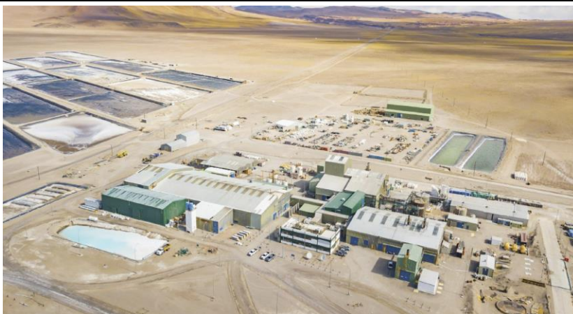
图表 60：由于采用吸附工艺，Hombre Muerto 盐湖上的 Fénix 提锂基地仅需要小规模的处理盐田
