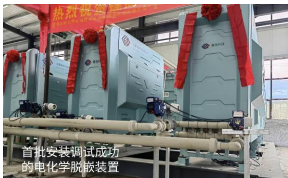
图表 115: 捌仟错盐湖的电化学脱嵌装置
