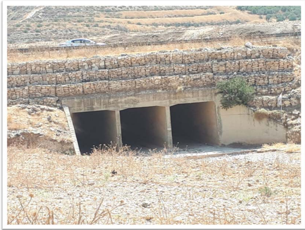
Figure 42: Wadi Tilala 3-Cell Box Culvert
