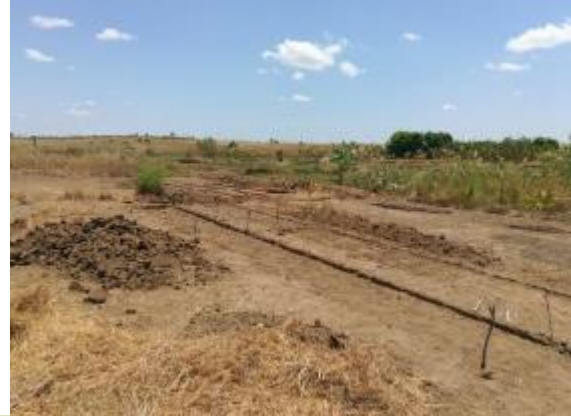
2 – Installation des piquets et traçage des platebandes
