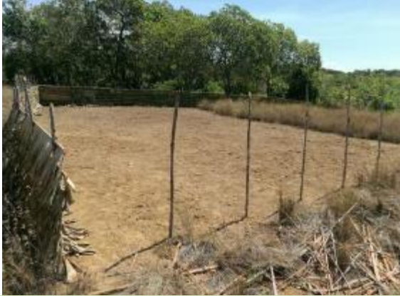
1 – Préparation du terrain
