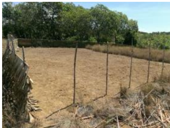
Photo 9 : Préparation du terrain (nettoyage et aplanissement) et mise en place de la clôture
