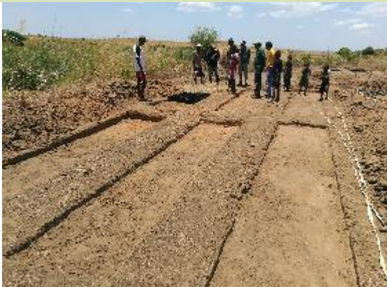
3 – Installation des platebandes et allées
