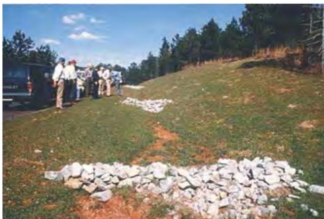
Una buena instalación de muros de contención de piedra, temporales. Recuerde atar los lados del muro de contención a las riberas superiores. La sección media deberá ser más baja. Limpiar los sedimentos a medida que se acumula. Remover los muros de contención una vez que el sitio y los canales se encuentren estabilizados con vegetación.
