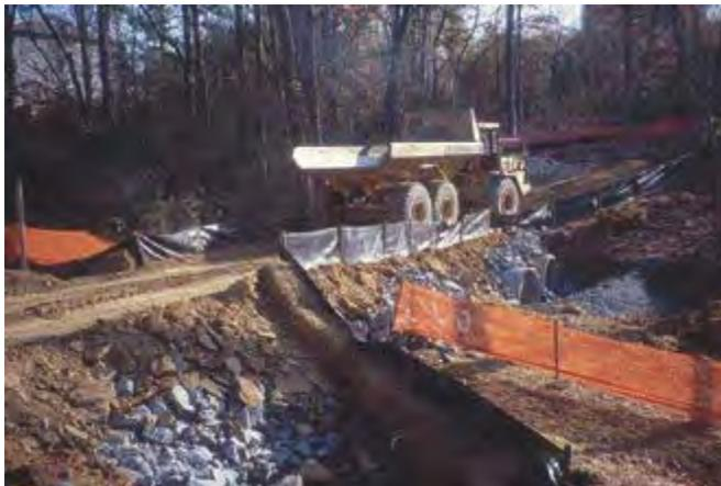
Cubra las alcantarillas con por lo menos 27 centímetros de tierra y por lo menos 15 cm de piedra combinada. Debería extenderse una capa gruesa de 8.5 metros de largo y 15 cm de espesor a lo largo de la carretera a cada lado del cruce.
