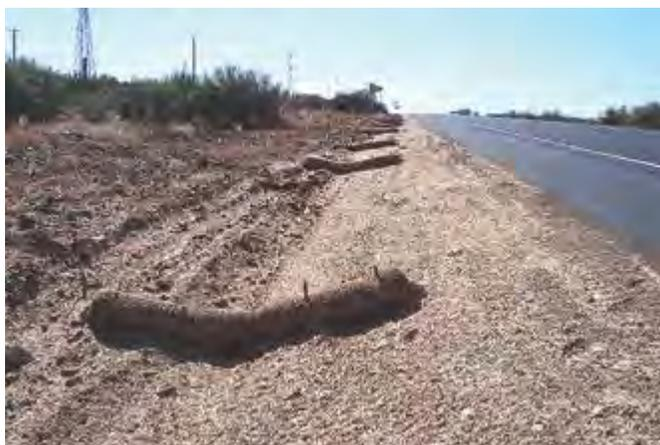
Buena colocación y espaciado entre los muros de contención de rollos de fibra. Cuando la pendiente no excede un tres por ciento, pueden utilizarse rollos de fibra de coco y otros productos comerciales.
