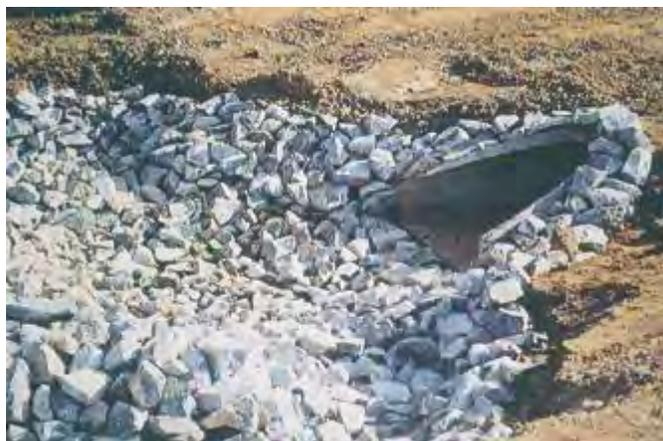
*Excelente emplazamiento y construcción de un estabilizador con rocas para disipar los flujos de la salida de la tubería. El área requiere que se siembre y una cobertura inerte.*
