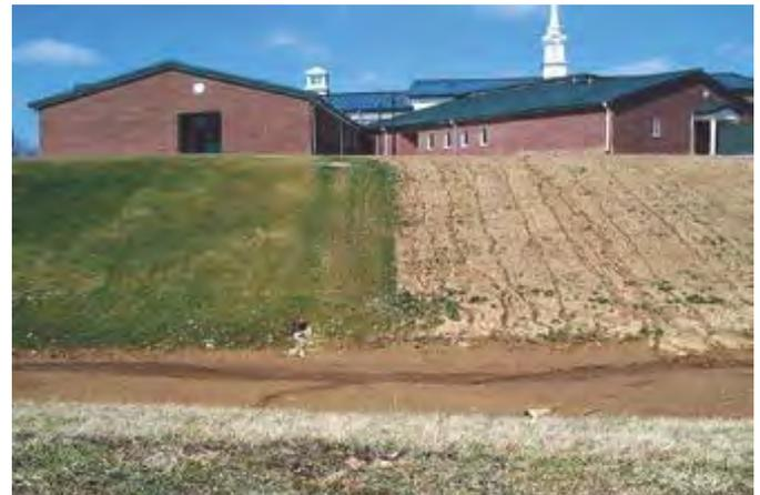
*En las áreas sembradas (lado izquierdo) virtualmente se elimina la erosión y la pérdida de sedimentos. En las pendientes sin siembras se forman rápidamente riachuelos o sumideros locales (derecha).*
