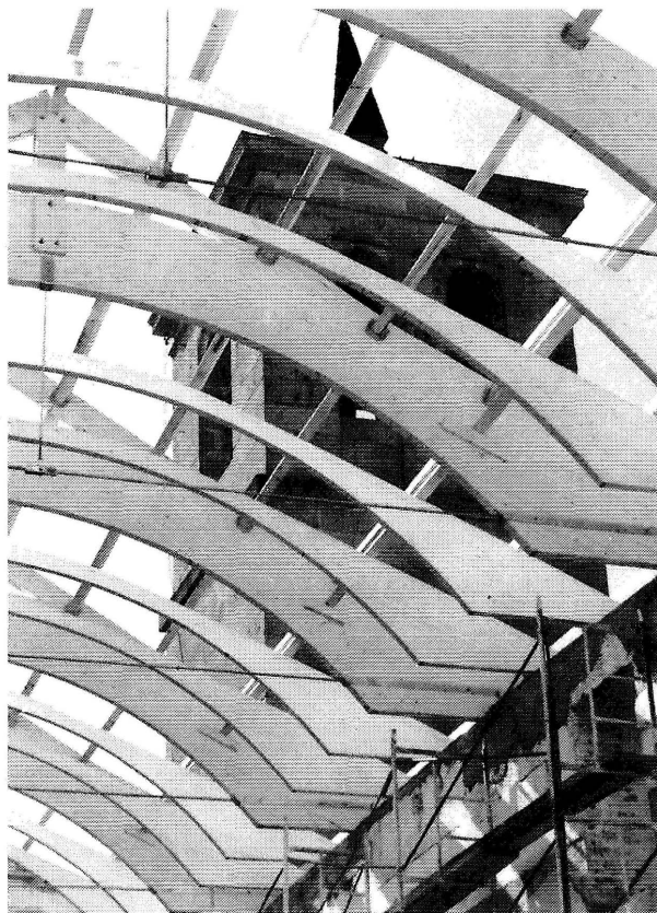
Iglesia de la Concepción. Chapinería. Nueva estructura de la cubierta.
