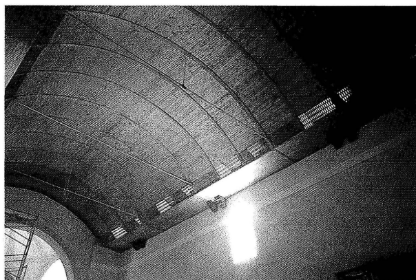
Iglesia de la Concepción. Chapinería. Detalle de la nueva cubierta.
