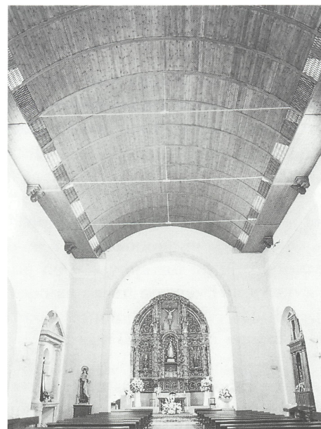
Iglesia de la Concepción. Chapinería. Interior restaurado.
