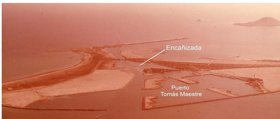
Imagen 1. Apertura de El Estacio para el paso de barcos a finales de los años 70.
