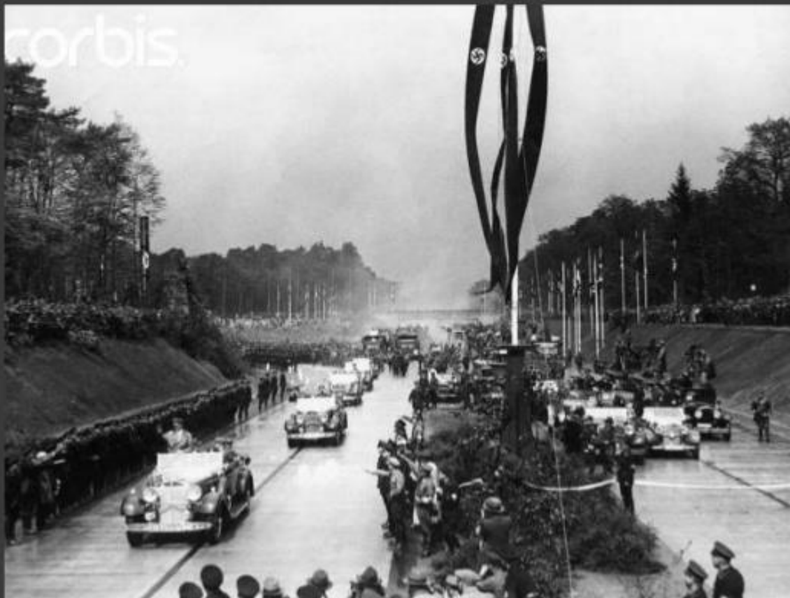
Uusi autobahn avataan
