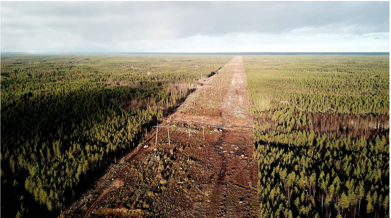
Kuva 33. Linjaus Lemetinkankaalta pohjoiseen; oikealla Lestijärven tvp:n uusi kaistale. Dronekuva pohjoiseen.
