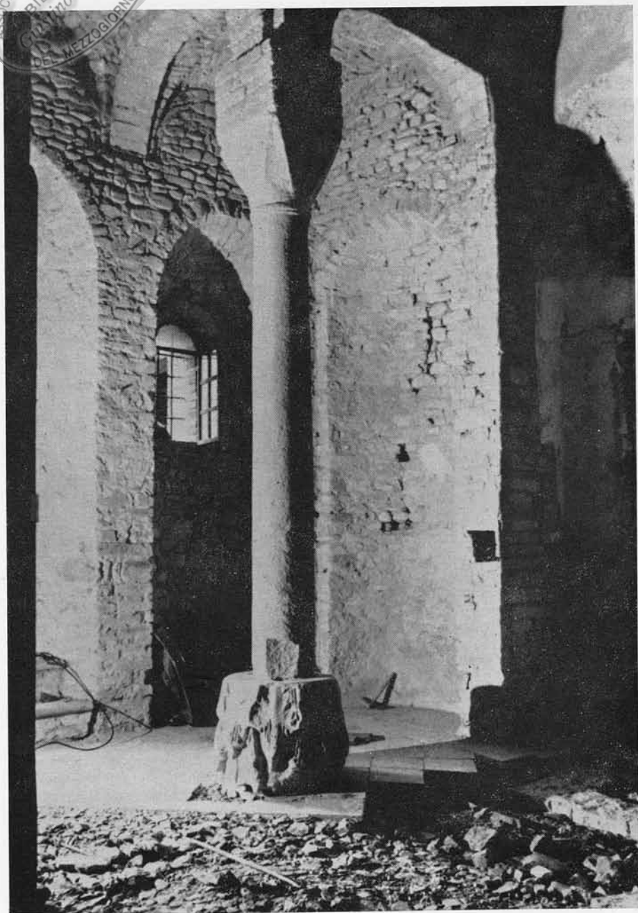
FIG. 4 — Paderna, S. Maria, interno: colonna NE. (foto Manzotti)
