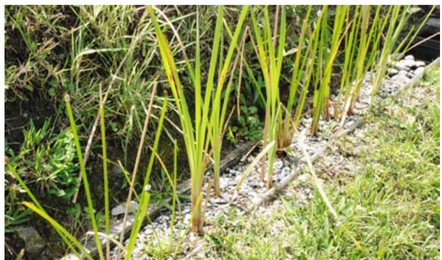
Humedal Artificial compuesto por plantas de Enea y piedras de 5 cms de diámetro.
