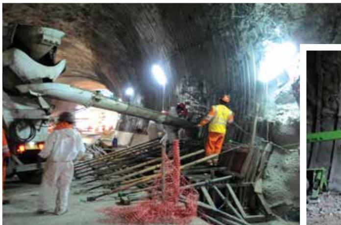
Instalación de cimbras y vaciado de concreto en zapata de revestimiento en el Túnel Sur.
