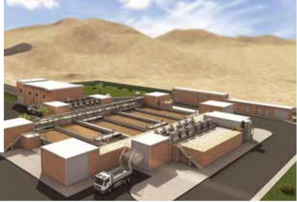
El proyecto comprende la construcción del túnel de 800 metros de longitud que conducirá los desagües a la Planta así como a la ejecución de las obras civiles y el montaje de los equipos electromecánicos y la instalación del emisor submarino.
