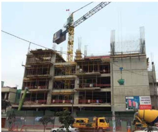
La obra se ejecutó con cimentaciones de zapatas conectadas. La mayoría de las losas son con viguetas prefabricadas, solo en las zonas de los cuartos técnicos y jardines se requirió de losas macizas.
