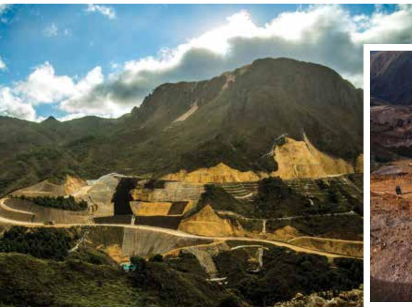
Las vías de acarreo minero para camiones de gran tonelaje deben ser construidas por capas con materiales adecuados cuya capacidad portante resista la máxima presión de la llanta del camión hacia la capa de rodadura.
