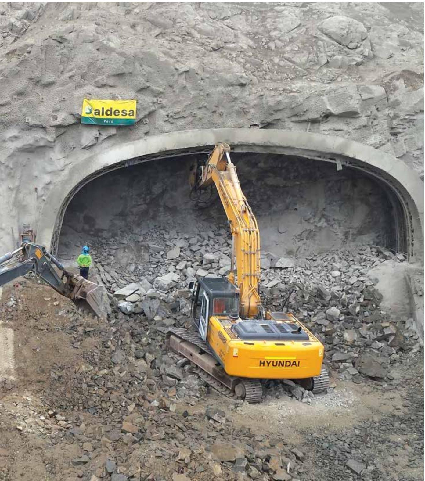
poca cobertura (menos de 8 metros), el sostenimiento instalado -a lo largo de los túneles- evita indeseables procesos de desestabilización tanto durante la construcción como en la vida útil del túnel.
