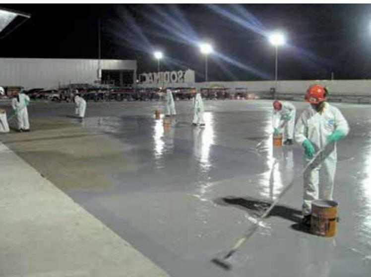
Para superficies expuestas al tráfico peatonal o vehicular, BASF emplea el sistema MasterSeal Traffic 1500, a base de resinas de Poliuretano.
