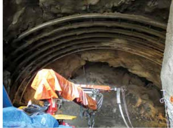
Trabajos de encofrado en la zona de derrumbe e instalación de cimbras y lanzamiento de shotcrete.
