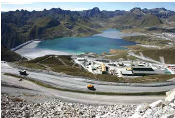
LAS BERMAS TIENEN TAMBIÉN DIMENSIONES QUE ESTÁN PREDEFINIDAS EN LAS GUÍAS, EN DÓNDE SE INDICAN QUE LA ALTURA TIENE QUE SER 2/3 DEL TAMAÑO DE LA LLANTA. “SI HABLAMOS DE UNA CAT 957 LA BERMA, QUE ES DE TIERRA CONFORMADA, ALCANZARÁ UNA ALTURA DE 2.50 M”.
