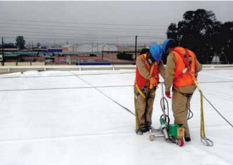
Estas soluciones evitan las filtraciones al interior de la obra, así como limita la transmisión de calor.
