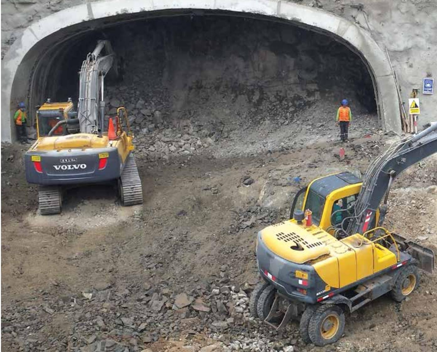
La construcción de los túneles a nivel en el cerro Puruchuco, surge como una alternativa al corte cerrado contemplado en el proyecto original. La sección transversal de cada túnel comprende la circulación vehicular (con tres carriles) y peatonal incluyendo veredas.
