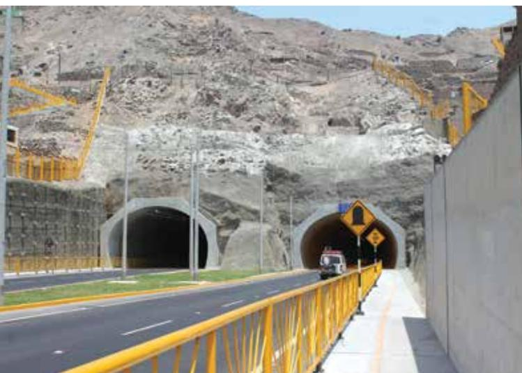
Ingreso y salida de los túneles desde la zona de San Juan de Lurigancho. Hacia el lado izquierdo se puede observar el muro de soil nailing empleado como muro de contención.
