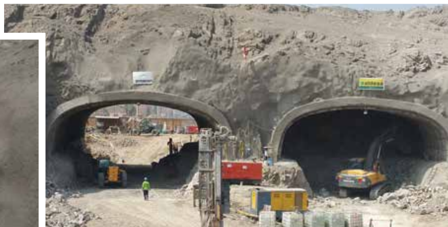
Hormigonado de la bóveda del falso túnel.
