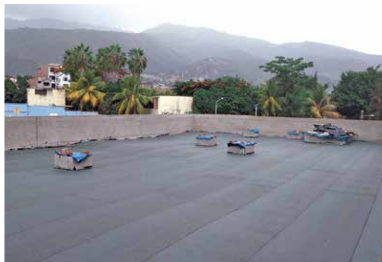
Techo del Hospital Jaén, en Cajamarca, impermeabilizado por Buildex.
