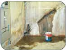
Etapa 2 Reparación de Estructura con Radmyx
