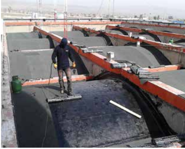
Geomembrana Nord Bitumi Arflex Extra MIN 4500 es recomendada para impermeabilizar coberturas, jardineras y techos jardín con pendientes a partir de 3%.
