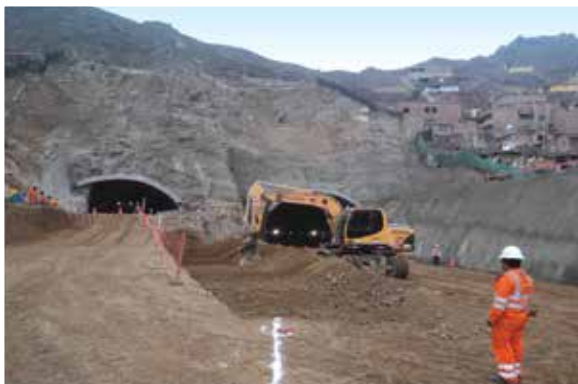
Trabajo de movimiento de tierras y colocación del asfalto en las vías de acceso al túnel
