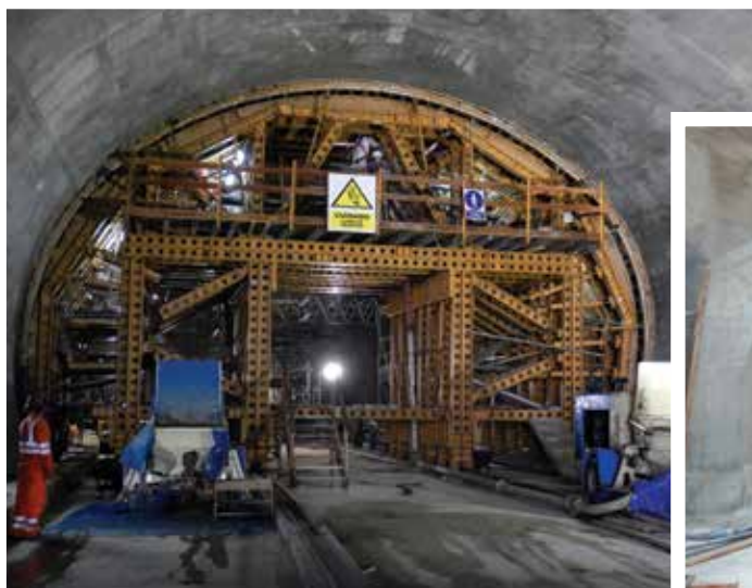
Vista del encofrado metálico que se utilizó para el revestimiento estructural de los túneles, específicamente para las fases de los portales, tramo curvo y transición en curva.
