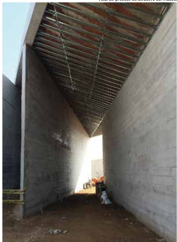
Vista del proceso constructivo del museo.
