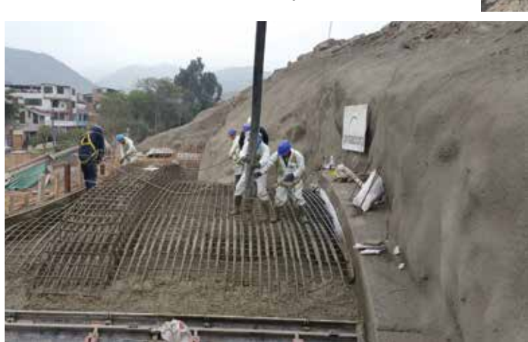
Hormigonado de la bóveda del falso túnel.
