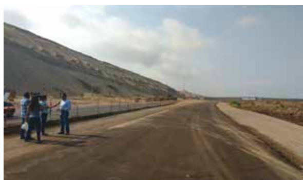
El ministro José Gallardo inspeccionando la construcción de la Doble Calzada de la Red Vial 6 (Chicha - Pisco).
