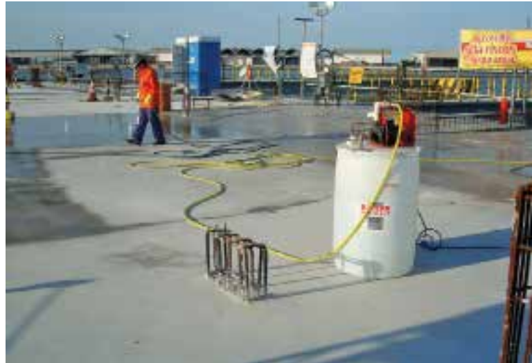
RADCON FORMULA # 7, es un impermeabilizante para techos de concreto macizo en estacionamientos aéreos.
