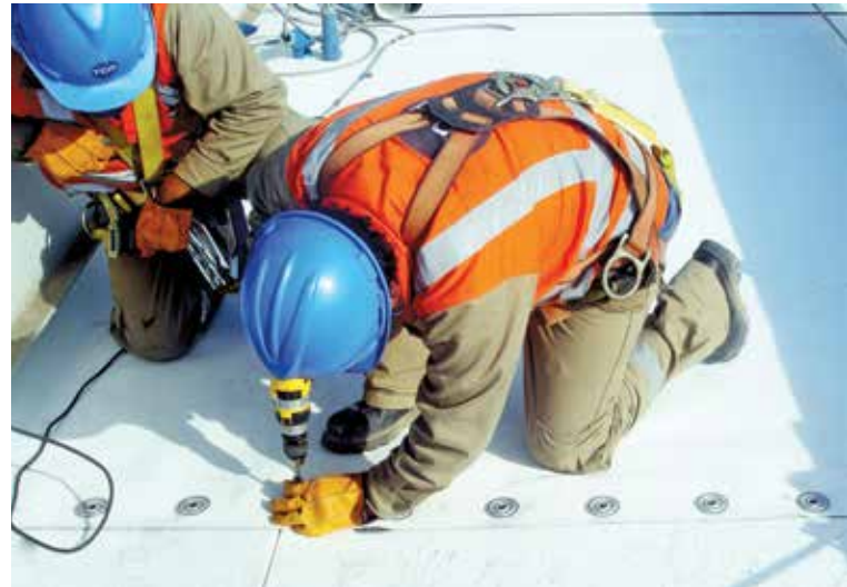
Los impermeabilizantes de TDM son aplicables a grandes superficies, como techos de centros comerciales, almacenes industriales, hospitales, entre otros.
