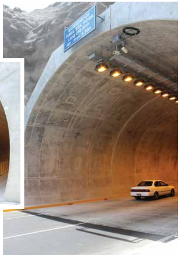
Portal de ingreso del túnel Santa Rosa de 258 m de longitud y gálibo de 5.30 m. El interior de ambos túneles cuenta con dos carriles más berma y vereda debido a su corta extensión no requiere de ventilación mecánica.
