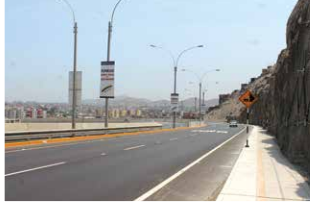
Vista del tramo vial del terraplén que se inicia en el cruce de las avenidas Prolongación Tacna y Alcázar, el cual fue resuelto con un muro de tierra armada de una altura máxima de 19.8 m.
