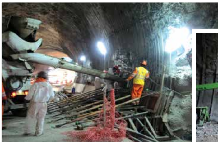
Instalación de cimbras y vaciado de concreto en zapata de revestimiento en el Túnel Sur.
