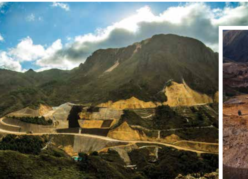
Las vías de acarreo minero para camiones de gran tonelaje deben ser construidas por capas con materiales adecuados cuya capacidad portante resista la máxima presión de la llanta del camión hacia la capa de rodadura.
