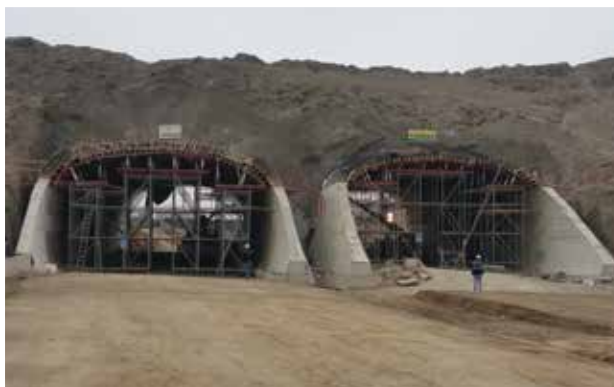
Vista general del portal oeste.
