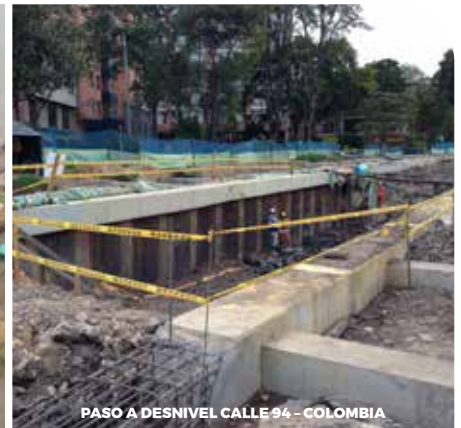
PASO A DESNIVEL CALLE 94 - COLOMBIA
