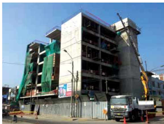
La obra se ejecutó con cimentaciones de zapatas conectadas. La mayoría de las losas son con viguetas prefabricadas, solo en las zonas de los cuartos técnicos y jardines se requirió de losas macizas.
