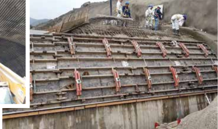
Instalación del encofrado para el falso túnel.
