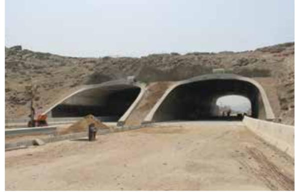
Los túneles de Puruchuco tienen una extensión total de 77 m de largo. La sección transversal comprende la circulación vehicular y peatonal, incluidas las veredas.
