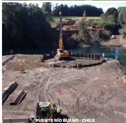
PUENTE RÍO BUENO - CHILE
