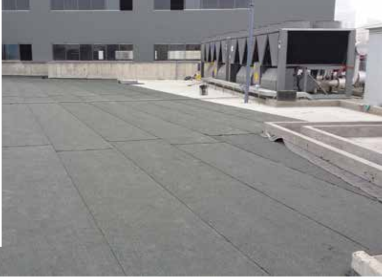
Geomembrana Nord Bitumi Arflex Extra MIN 4500 es recomendada para impermeabilizar coberturas, jardineras y techos jardín con pendientes a partir de 3%.
