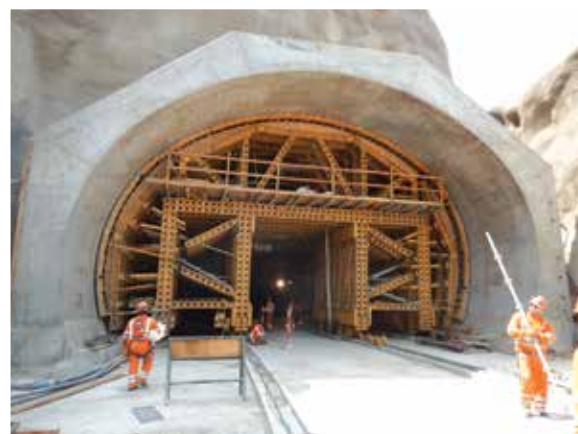
Vista del encofrado metálico que se utilizó para el revestimiento estructural de los túneles, específicamente para las fases de los portales, tramo curvo y transición en curva.
