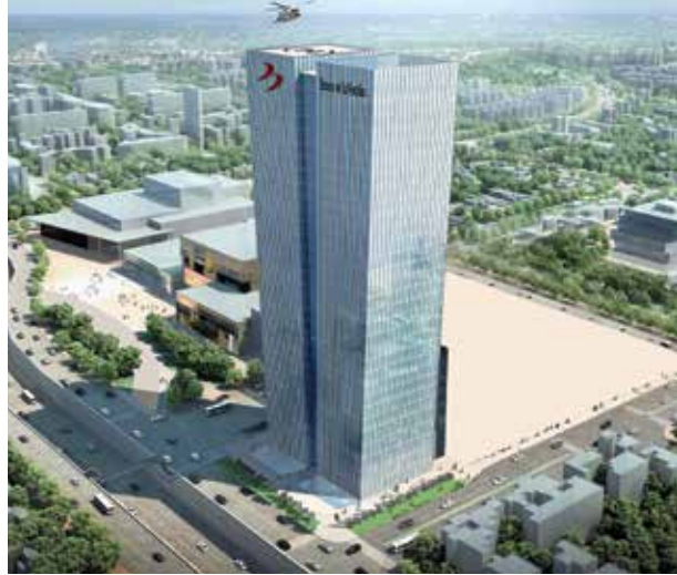
En el Nuevo Edificio del Banco de la Nación, Refricorp instaló equipos centrales de agua helada, conocidos como Chiller.
