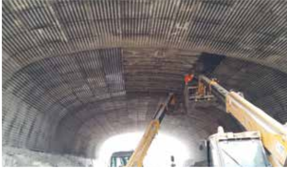
Colocación de la chapa Bernold.
