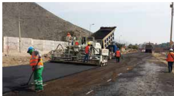
Los accesos al túnel son con pavimento flexible.
