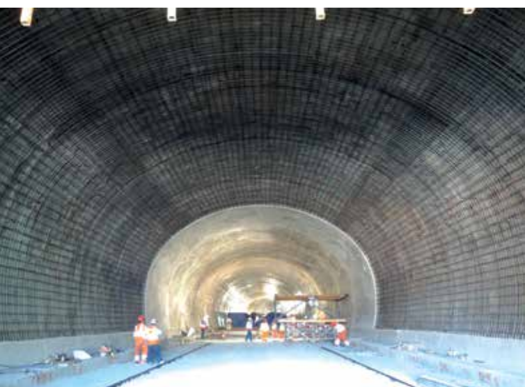
Trabajo final de armadura de acero en túnel Norte.
