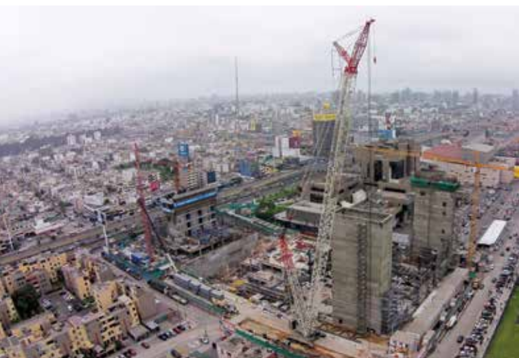
Terex Superlift 3800 consta de una capacidad de 650 ton. y podría alcanzar una altura máxima de 174m y levantar cargas de hasta 80 ton.
