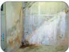
Etapa 3 Reparación Exitosa con Radmyx
