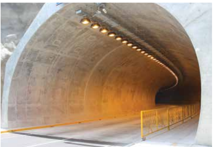
Portal de ingreso del túnel Santa Rosa de 258 m de longitud y gálibo de 5.30 m. El interior de ambos túneles cuenta con dos carriles más berma y vereda debido a su corta extensión no requiere de ventilación mecánica.
