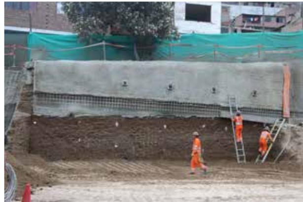
Colocación del anclaje del soil nailing a la salida del túnel Santa Rosa en SJL.
