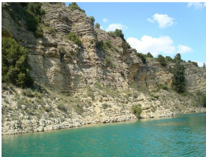
Laderas en la Formación Yátova con riesgo de desprendimientos en el embalse del Arquillo de San Blas.
