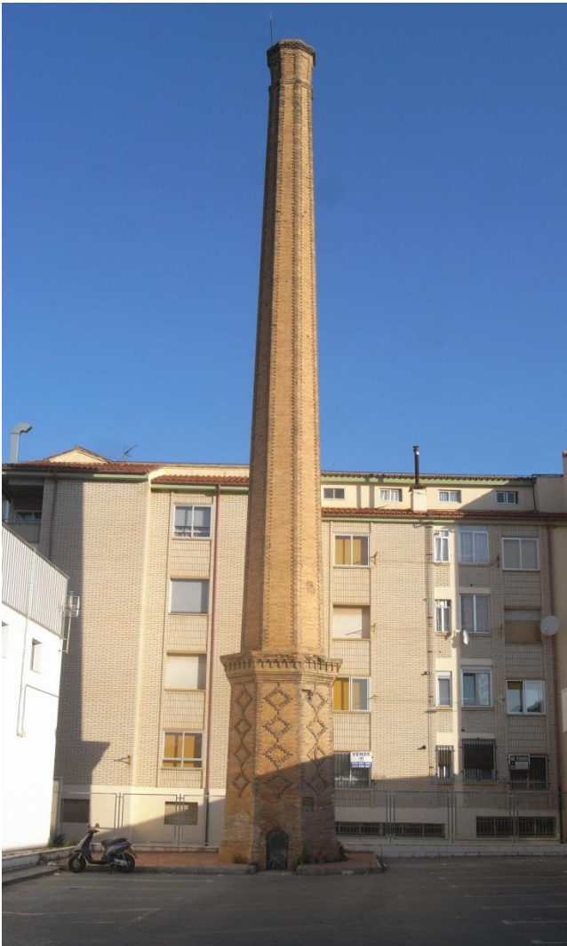
Imagen de la chimenea
