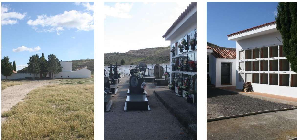
Vistas parciales del cementerio del barrio rural de Villalba Baja - Fuente: Oficina PGOU
