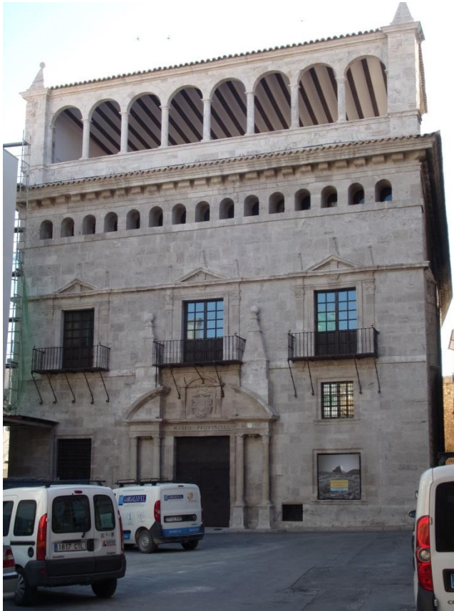
Imagen del Palacio Casa de la Comunidad
