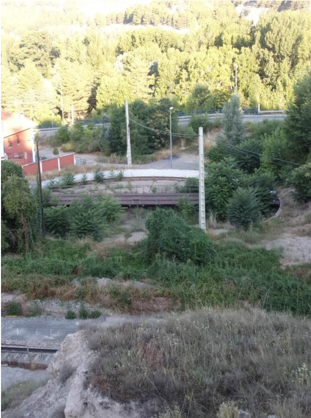
Imagen del puente
