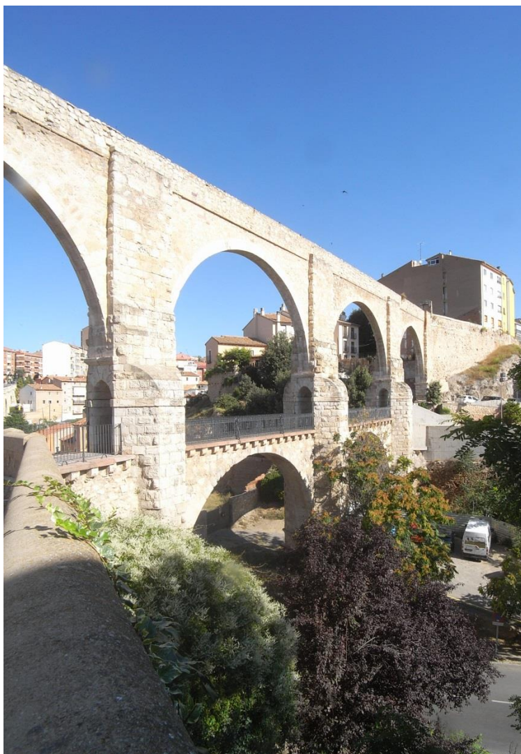
Imagen parcial del acueducto
