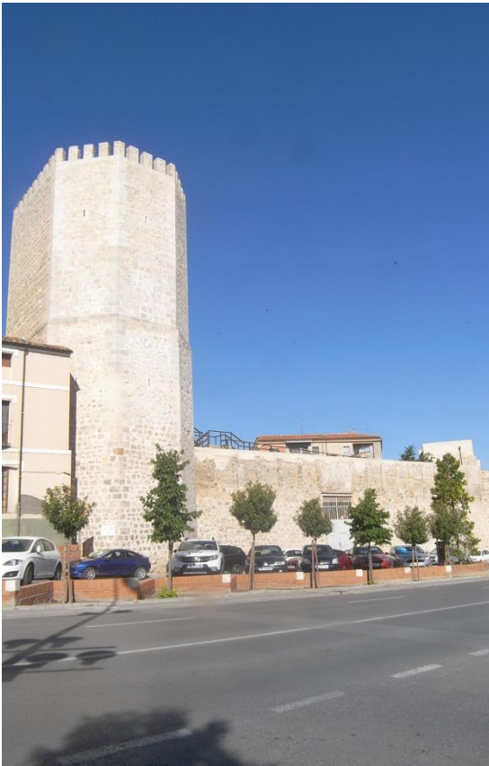
Imagen parcial de la muralla
