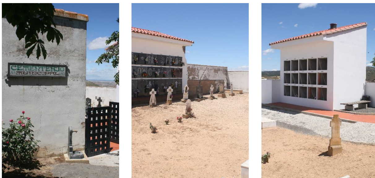
Vistas parciales del cementerio del barrio rural de Aldehuela - Fuente: Oficina PGOU
