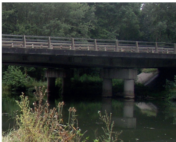
Figure 19 : Ligne de piles composée de colonnes
