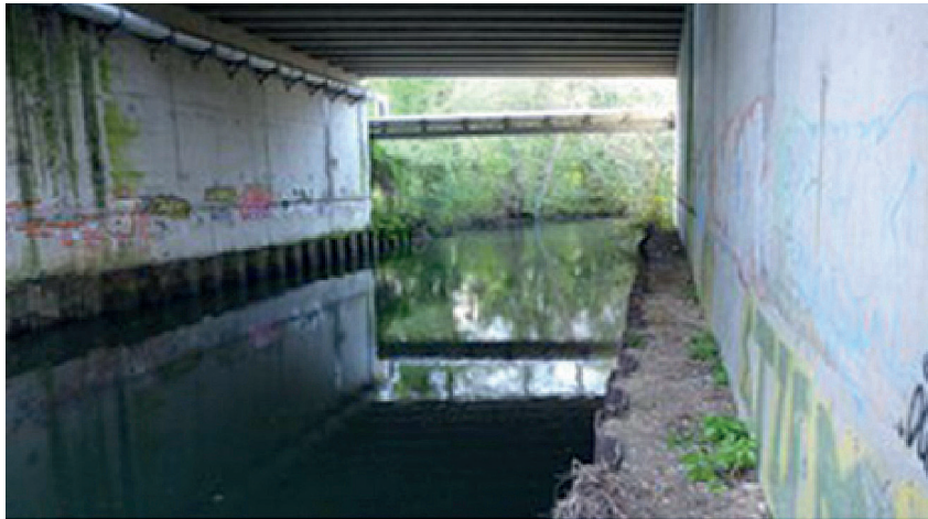
Figure 42 : Pont sur l'Auxance, Chasseneuil-du-Poitou [30] (Source : Cerema)
