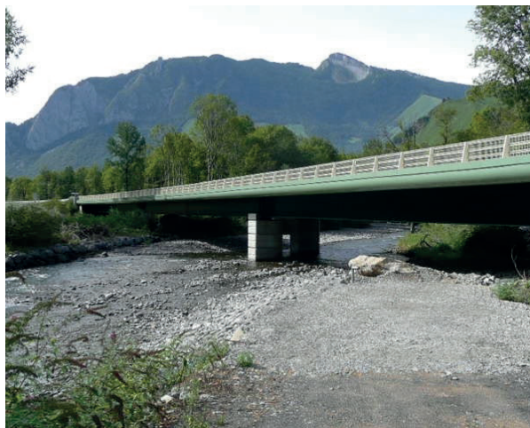
Figure 7 : Ouvrage en zone torrentielle au débouché hydraulique largement dimensionné (Source : DIR Atlantique)
