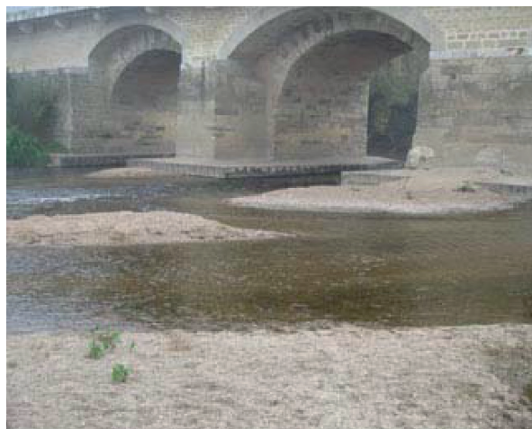
Figure 18 : Exemple de bancs d'alluvions à nu indiquant un lit mobile (Source : LR de Blois)
