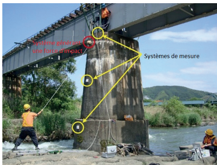
Figure 33 : Mesure vibratoire d'une pile de pont au Japon destinée à quantifier la perte de rigidité des fondations liée au phénomène d'affouillement [31] (Source : Shinohana et al.)
