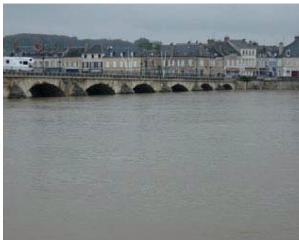
Figure 9 : Ouvrage fluvial au débouché hydraulique sous dimensionné (Source : LR de Blois)
