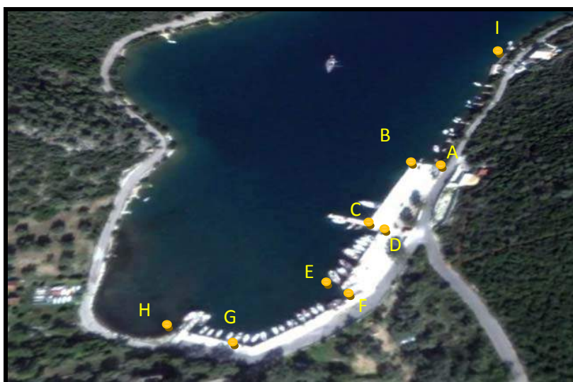
Εικόνα 6-3: Άποψη υφισταμένων λιμενικών εγκαταστάσεων στο όρμο Αθερινού (Πηγή:Google)
