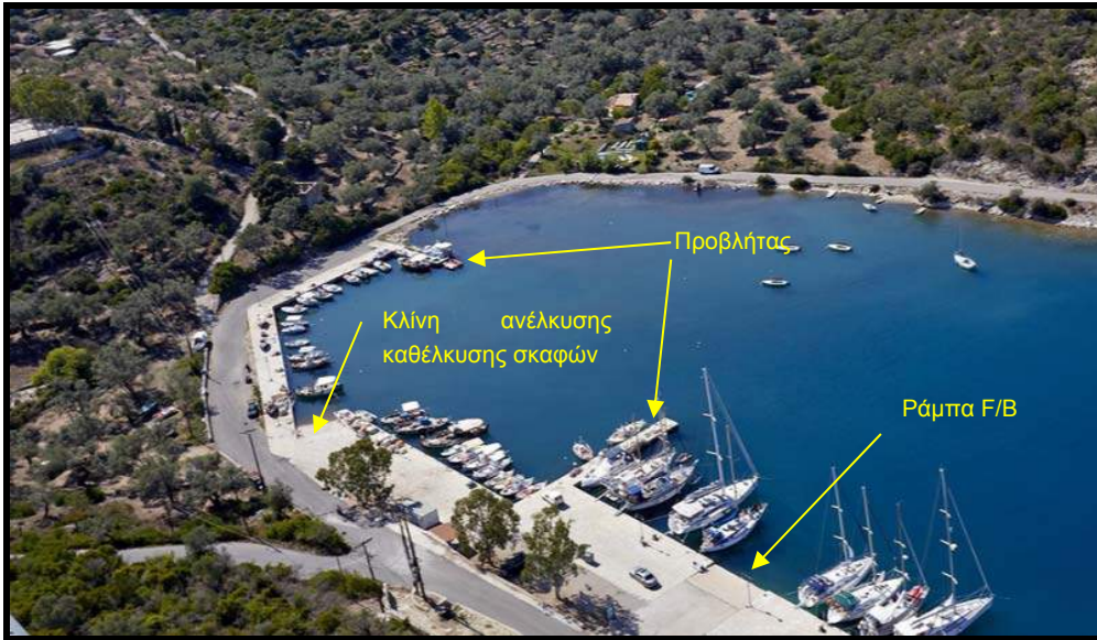
Αεροφωτογραφία 4.1.A4-2 Άποψη υφισταμένων λιμενικών εγκαταστάσεων στο όρμο Αθερινού
