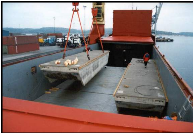
Εικόνα 13-8: Παράδειγμα εφαρμογής - Μεταφορά Στοιχείων Πλωτού Κυματοθραύστη Σκυροδέματος
