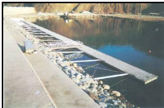
Εικόνα 6-10: Παράδειγμα εφαρμογής για την αγκύρωση του πλωτού διαδρόμου
