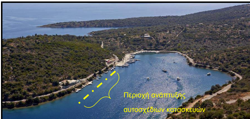
Αεροφωτογραφία 4.1.A4-3 Άποψη υφισταμένων λιμενικών εγκαταστάσεων στο όρμο Αθερινού
