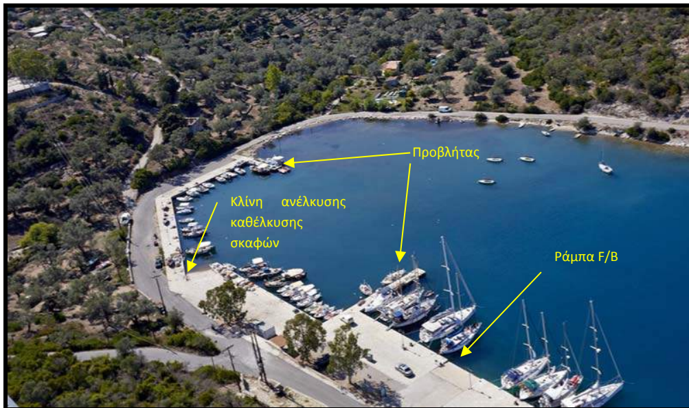
Εικόνα 6-4: Άποψη υφισταμένων λιμενικών εγκαταστάσεων στο όρμο Αθερινού (Πηγή:Google)
