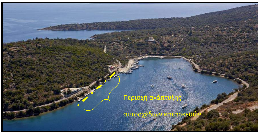
Εικόνα 6-5: Άποψη υφισταμένων λιμενικών εγκαταστάσεων στο όρμο Αθερινού (Πηγή:Google)
