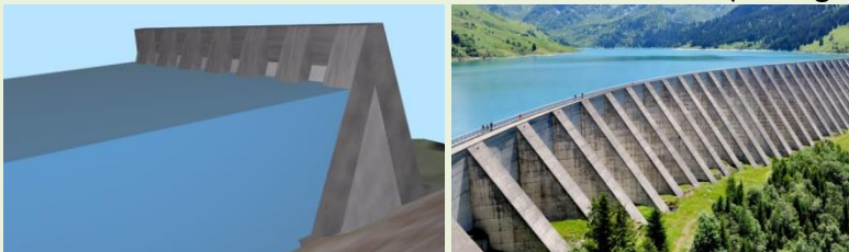
Barrage à contreforts : le mur du barrage est conforté par tout un ensemble de structures, en contrefort.
