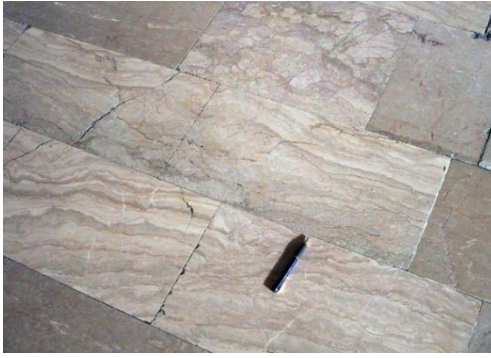
Dalles en calcaire du Boulonnais (pavage de la Gare Austerlitz)
