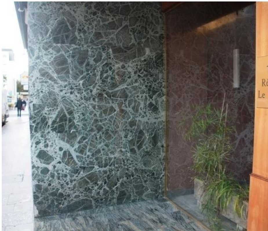
Serpentine utilisée en pierre de parement d'un hôtel © P. De Wever
