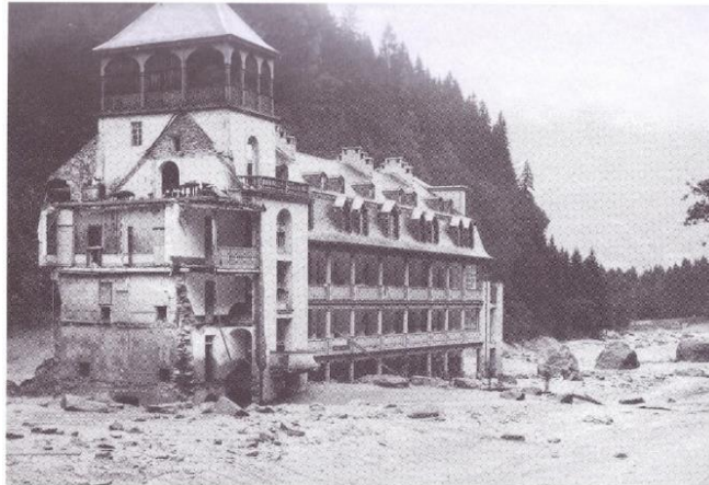
Établissement thermal envahi par la coulée torrentielle.
