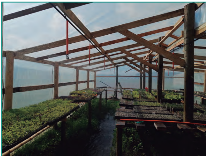
Figura 11. Sistema de riego presurizado en almacigueras
