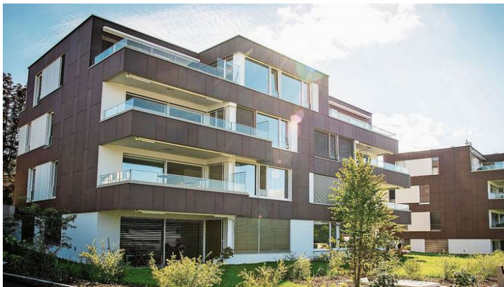
Verschiedenfarbige Solarmodule zieren die Fassade der Wohnüberbauung in Männedorf.
