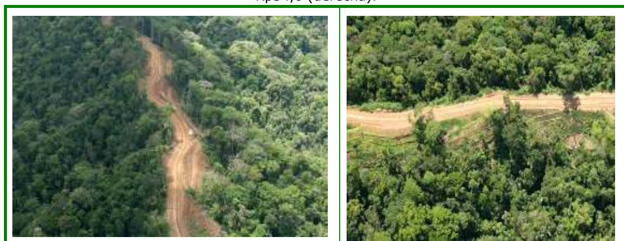
Figura 22. Derecho de vía usado aún para tránsito y taludes con obras de revegetación en el Kp36,0 (izquierda). Taludes en gran parte revegetado y DdV aún con suelo desnudo Kp34,0 (derecha).
