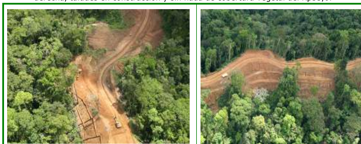
Figura 23. Obras de reconstrucción de taludes en el Kp37,3 (izquierda). En la foto de la derecha, taludes en construcción y sin nada de cobertura vegetal del Kp35,6.
