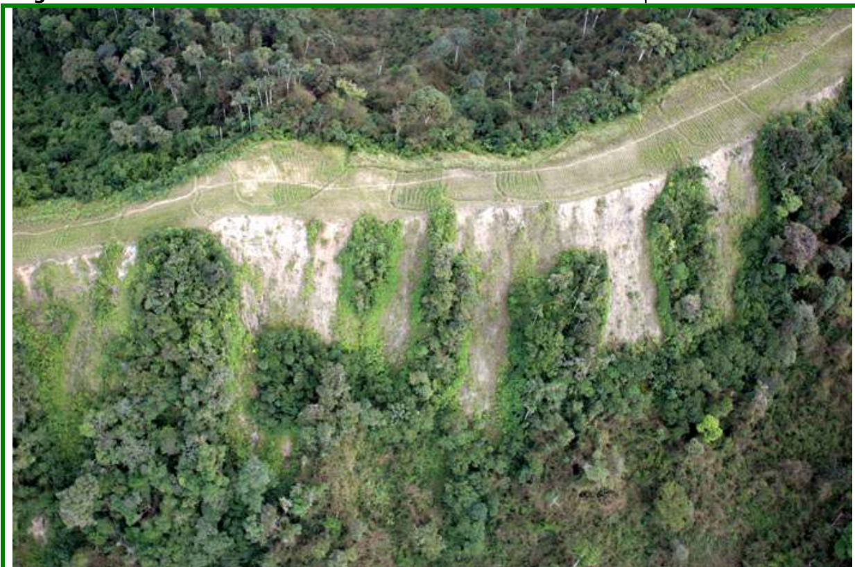
Figura 36. Sector con varias cicatrices de deslizamiento inducidos por las obras del STD.
