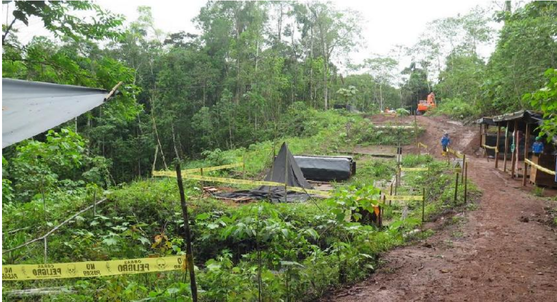
Figura 8: Obras de restauración de taludes en la progresiva Kp15+900 en noviembre de 2018
