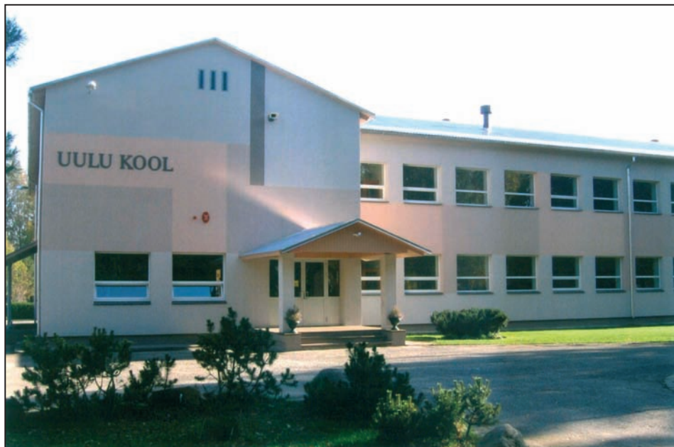
Renoveeritud Uulu kool.
