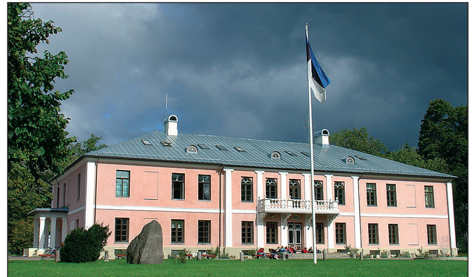
Renoveeritud Tõstamaa mõisakool.
