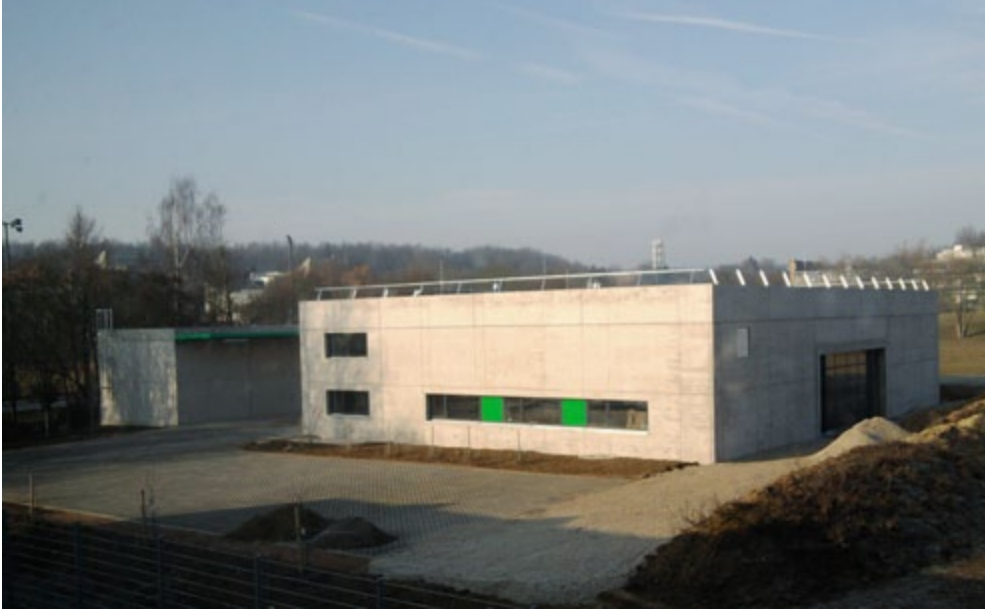
Fertiggestellter Rohbau der neuen Gärtnerhalle
