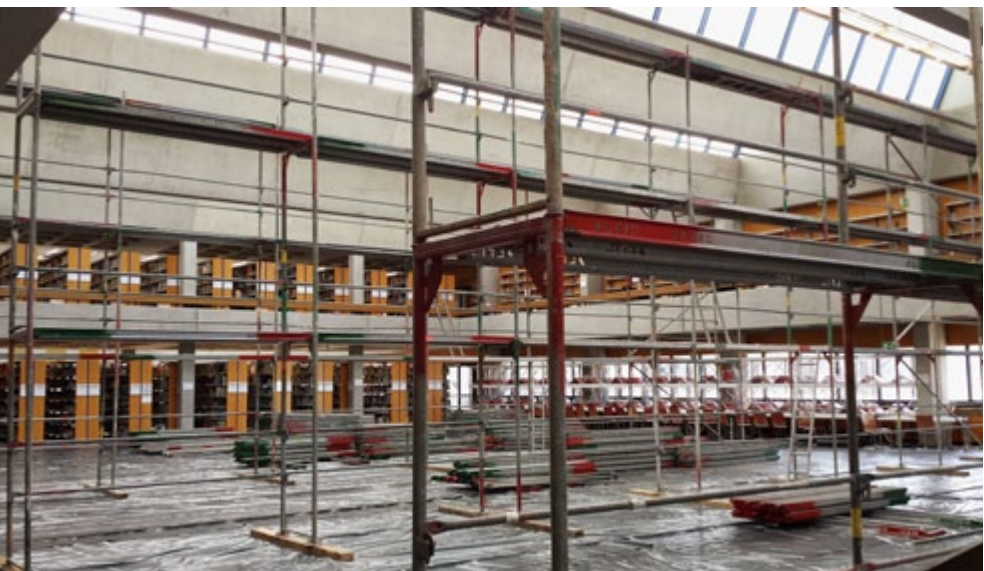
Baustelle im Lesesaal PT
