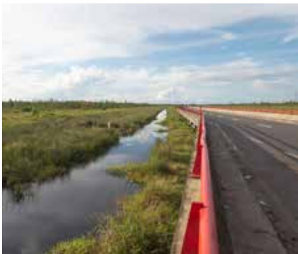
Jalan memfasilitasi akses, aktivitas ilegal dan permukiman. Disini, kanal drainase dibuat melewati area gambut di Kalimantan Tengah.
