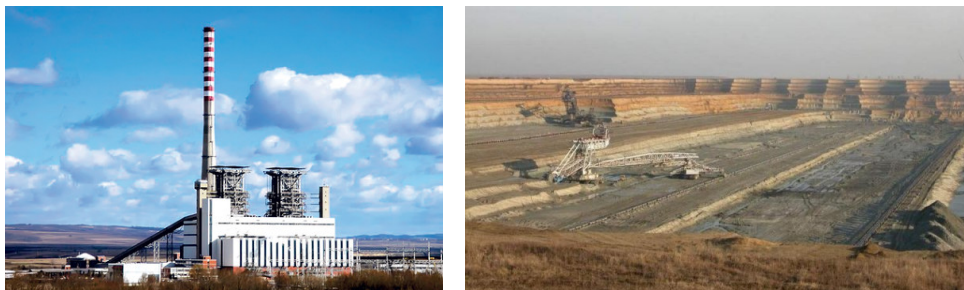
Слика 8: Привредно друштво «Термоелектране и копови Костолац»
