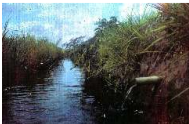
Figura 3. Ponto de descarga de um dreno lateral no coletor na área DS 2 na FEVC, Pentecoste-CE
