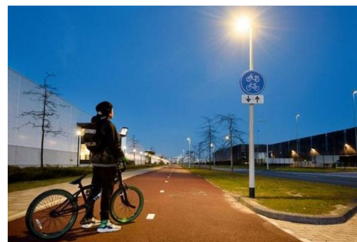
Imatge 47: Smart street lightning project
