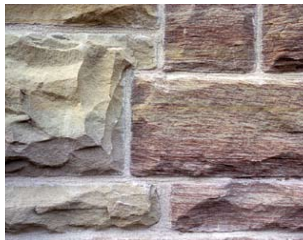
Abb. 64 Schilfsandstein in typischen Varietäten, Mauersteine am Marktplatz von Bühlertann.
