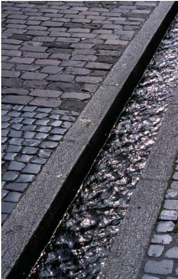
Abb. 194 Gesteinsbaustoffe ermöglichen die Zu- und Ableitung von Wasser. „Bächle“ in der Freiburger Innenstadt.
