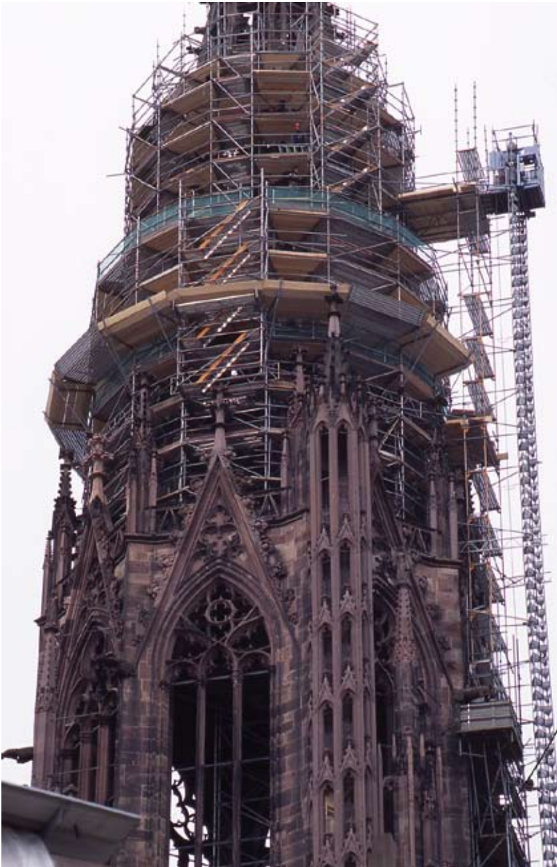
◀ Abb. 71 Aus Buntsandstein errichteter Hauptturm des Freiburger Münsters, der seit Sommer 2006 nur noch eingerüstet zu sehen ist. Große Mengen an verwitterungsbeständigem Buntsandstein werden zur Restaurierung benötigt.
