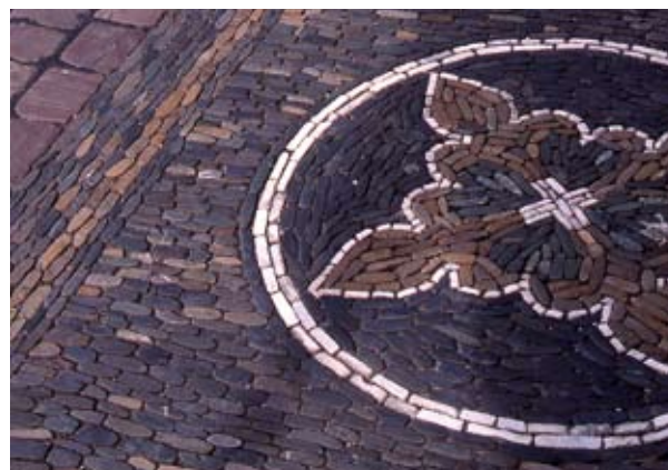
Abb. 9 Gesteinsrohstoffe begleiten uns auf Schritt und Tritt: Beispiel aus der Freiburger Altstadt, Straßenpflaster aus Buntsandstein (rotbraun) und Kiesgeröllen aus dem Rhein.
