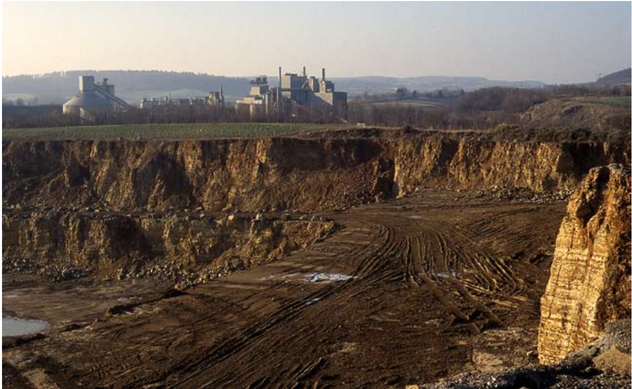
Abb. 51 Zementwerk bei Wössingen: Rohstoffgewinnung und -verarbeitung erfolgen in unmittelbarer Nachbarschaft.
