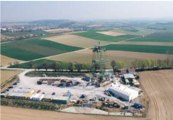
Abb. 172 Luftaufnahme des neuen Schachtes „Konradsberg“ der Grube Heilbronn 2003.
