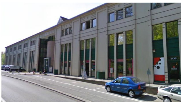
Photo 5 : Vue d'une partie du bâtiment Roosevelt Office Center depuis le nord de l'avenue F. Roosevelt (Source : Google Street View, 2009)
