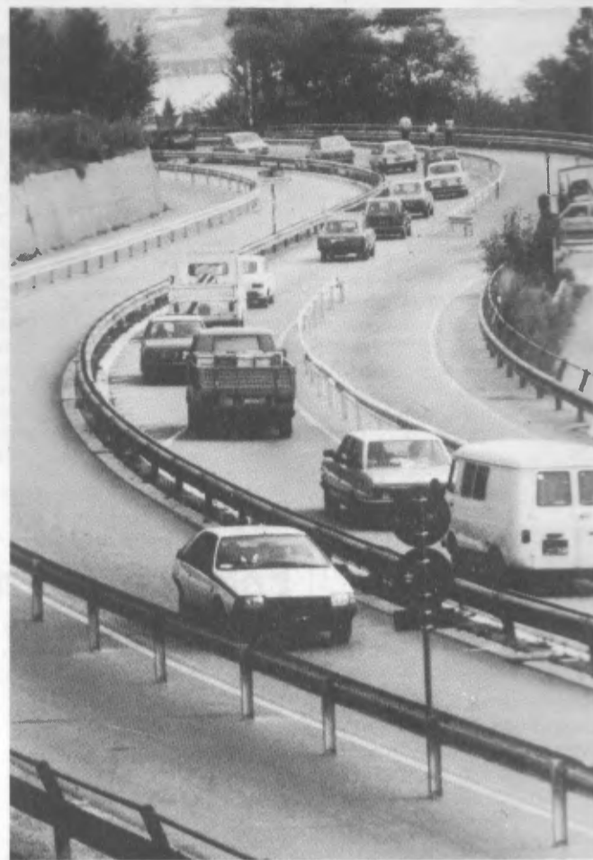
I nuovi guardrail installati sulla Statale 36.
