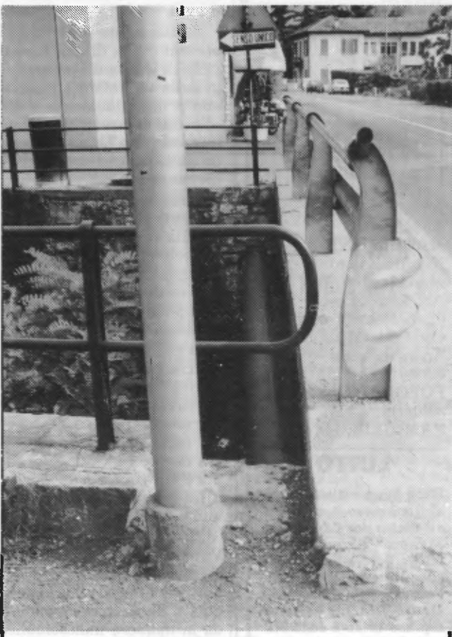
Uno dei due famigerati e impraticabili salvagenti ANAS da sostituire con idonei marciapiedi sul torrente Zerbo.
