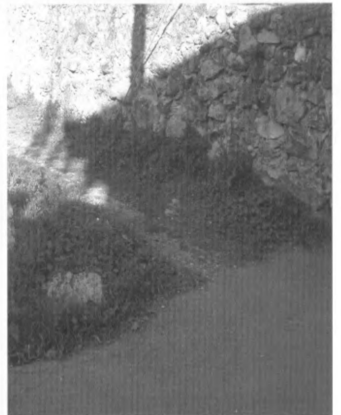
IL PERICOLOSO ACCESSO DELLA STRADA
