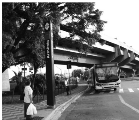
Figura 2 – Estação Armênia (início de operação em set.1975).
