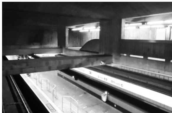
Figura 4 – Estação Sé (início de operação em fev.1978). Fonte: Barbosa, M.B. jan.2012.
