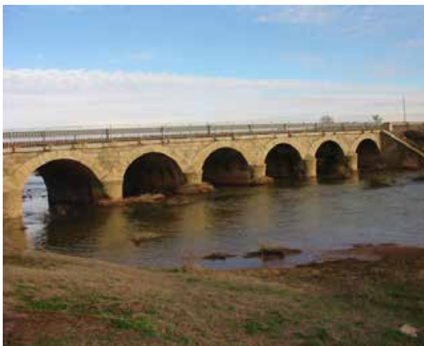
Actual puente de San Andrés sobre el río Algodor
