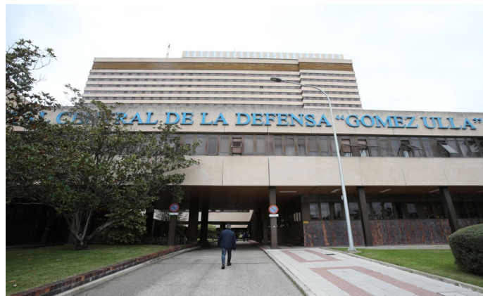
Imagen 1. Hospital Central de la Defensa «Gómez Ulla» (Madrid, España). Fotografía de los autores.
