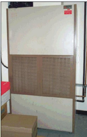
évacuateur d'un système de climatisation
