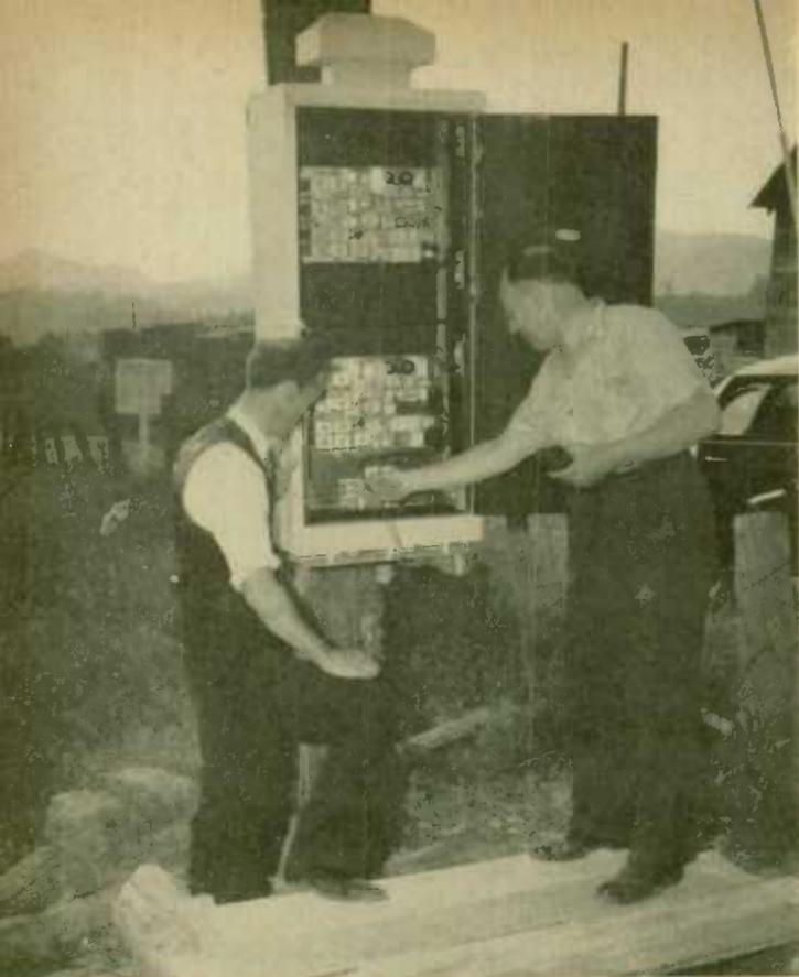
L'extension des facilités téléphoniques aux régions reculées est un problème économique que l'on vient de résoudre dans le village laurentien de Lac-Supérieur en utilisant les lignes d'énergie pour le courant téléphonique. L'illustration fait voir l'essai de l'autillage qui superpose le courant téléphonique relativement faible sur le circuit d'énergie.
