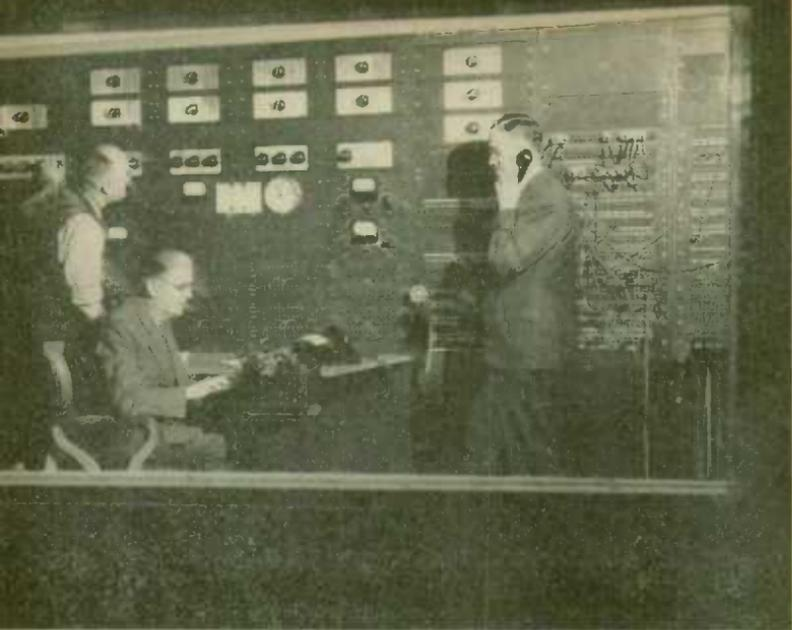
La principale salle de contrôle — centre nerveux des studios de Radio-Canada à Toronto; 38 programmes peuvent être contrôlés simultanément au moyen de ce tableau.
