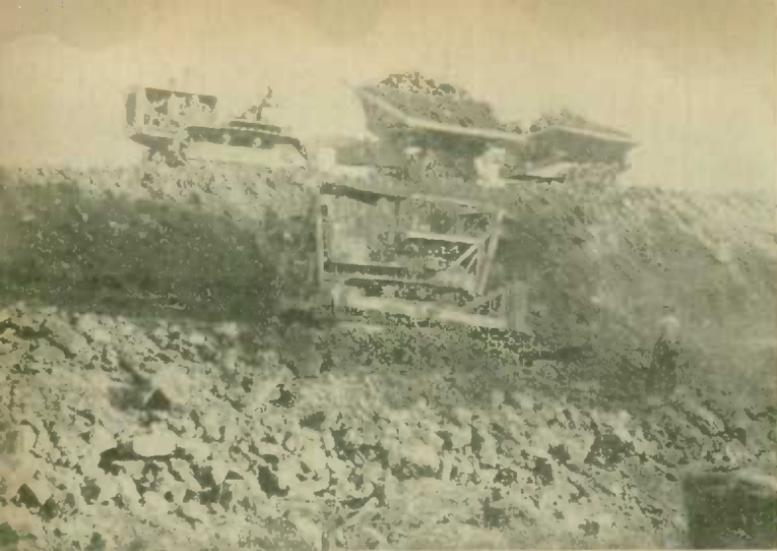
*Remplissage et aménagement de la pente de l'encaissement d'une route. Le matériel de remplissage est déversé par les wagonnets à bascule et nivelé par le bulldozer.*
