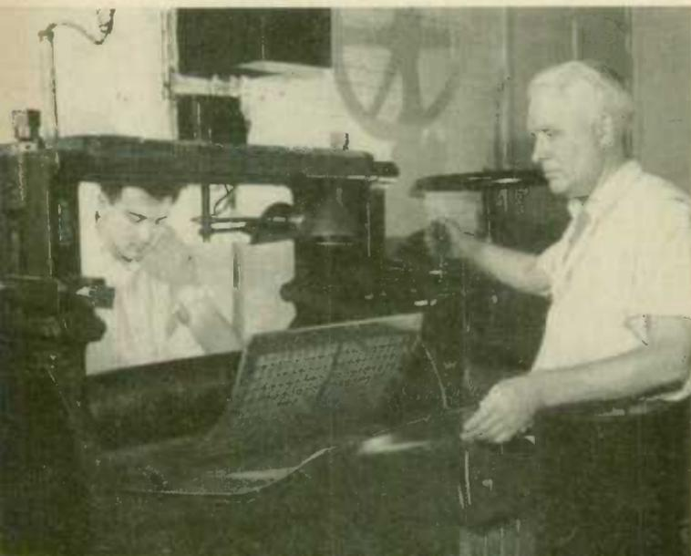
Deux conducteurs de machines cintent une plaque d'acier gravée afin de l'ajuster au cylindre d'une presse à imprimer les timbres-poste.
