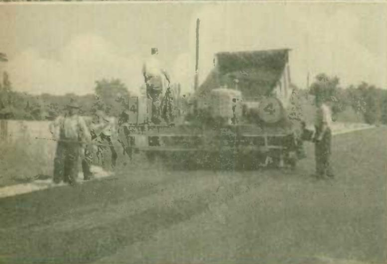
*Revêtement d'une section de route en asphalte. Les grandes routes du Canada sont pavées de bitume de cette façon sur des milliers de milles. La machine, alimentée par le camion à bascule de l'arrière, est réglée pour déposer une couche d'asphalte de l'épaisseur requise.*
