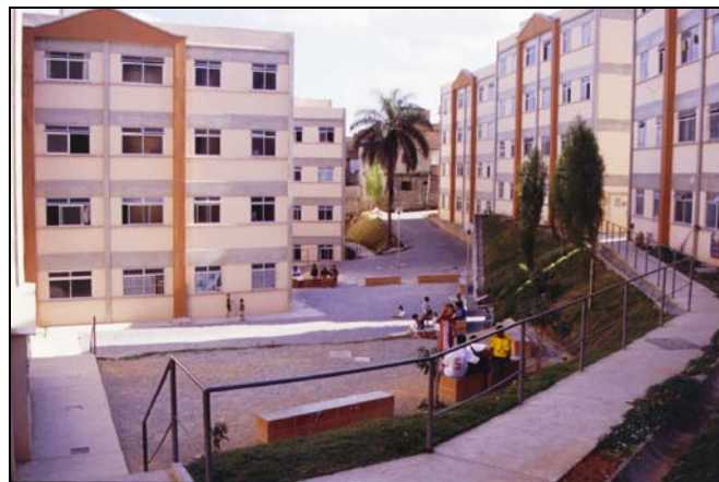
Belo Horizonte Housing Conjunto. 192 Units.
