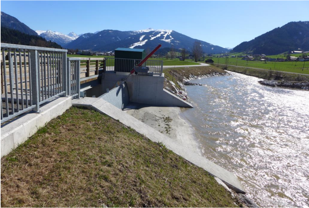
Abb. 6: Einlaufbauwerk für das Retentionsbecken in Altenmarkt (Quelle: Eigene Aufnahme).
