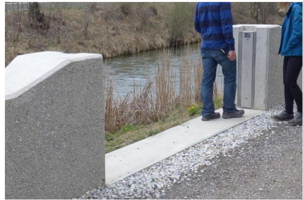
Abb. 34: Öffnung in der Hochwasserschutzmauer (Quelle: Eigene Aufnahme).
