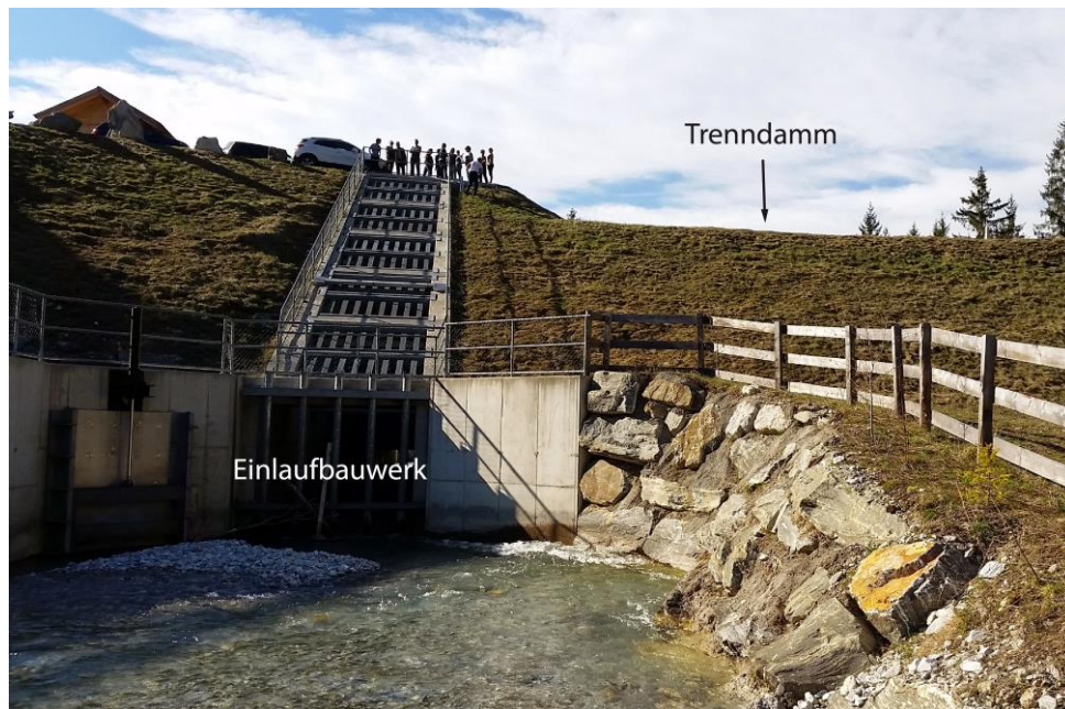
Abb. 7: Retentionsbecken Pleißling (Quelle: Eigene Aufnahmen).
