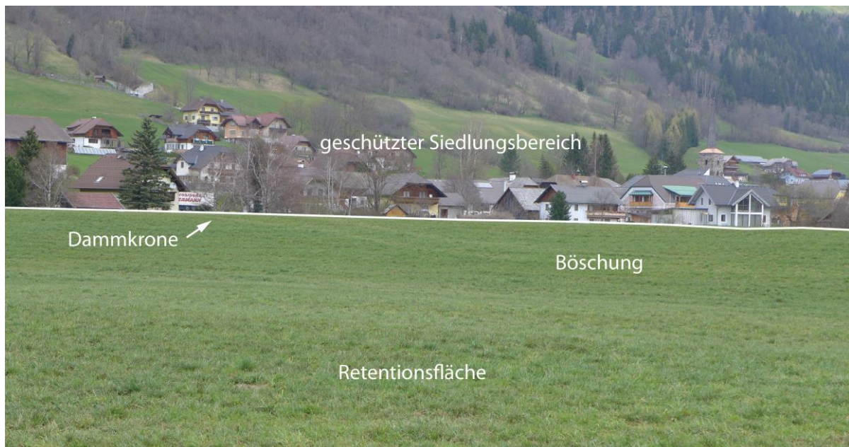
Abb. 37: Retentionsfläche Hochwasserschutz Unternberg (Quelle: Eigene Aufnahme).
