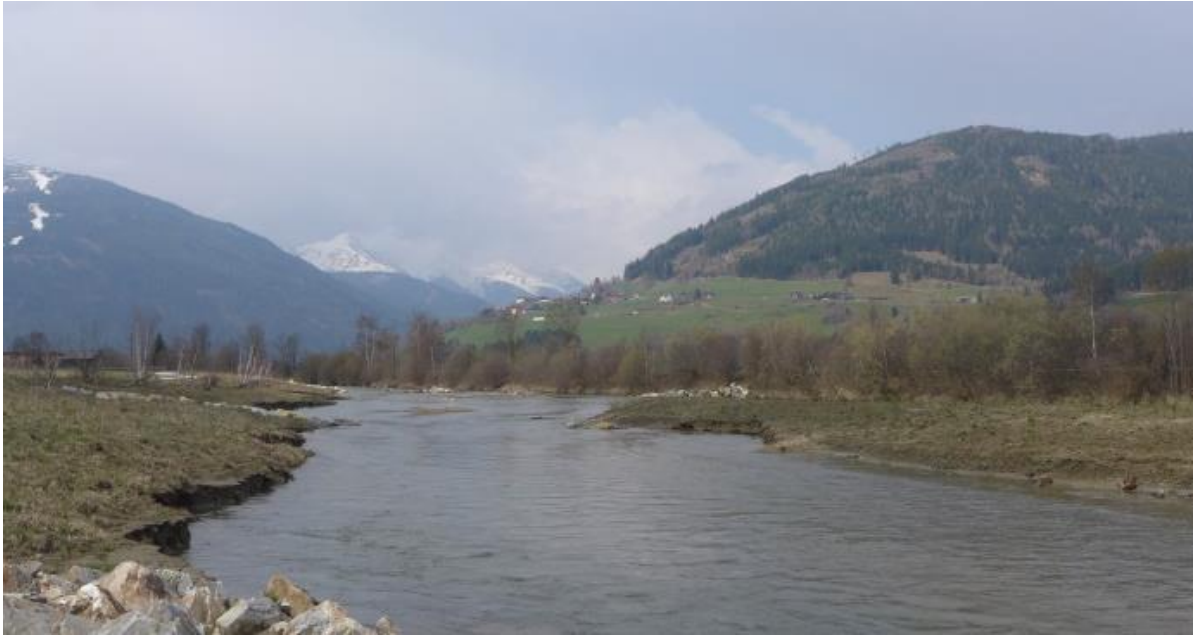
Abb. 36: Flussaufweitung Hochwasserschutz Unternberg (Quelle: Eigene Aufnahme).
