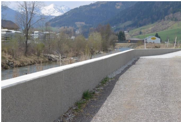
Abb. 35: Hochwasserschutzmauer Unternberg (Quelle: Eigene Aufnahme).
