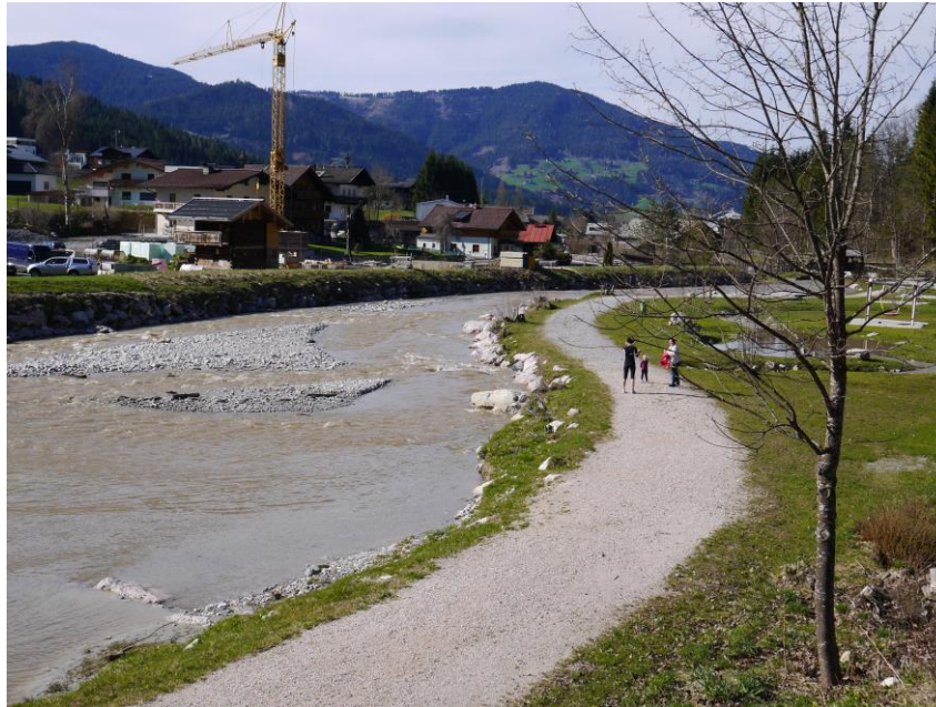
Abb. 19: Retentionsfläche mit entsprechenden Pflegemaßnahmen in Flachauwinkl (Quelle: Eigene Aufnahme).
