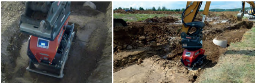
Abbildung 1. Anbauverdichter auf der Kanalgrabenhauptverfüllung mit Anzeigedisplay
