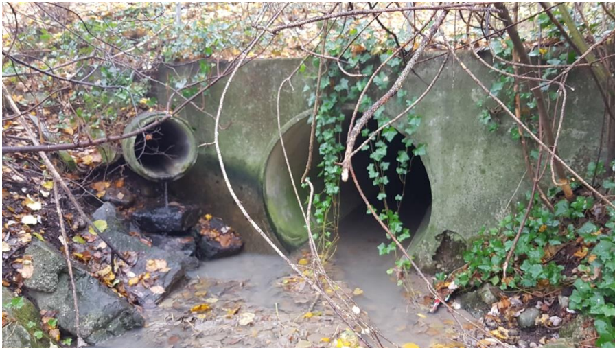
Auslauf Durchlass Blumenwies, Betonrohr DN1250
