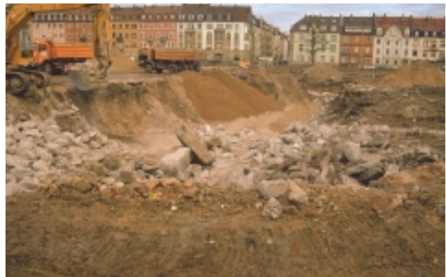
Abb. 1: Baureifmachung für die zukünftige Nutzung im Rahmen des Flächenrecyclings einer Altlast [Foto: Blankenhorn, Stadt Karlsruhe].
