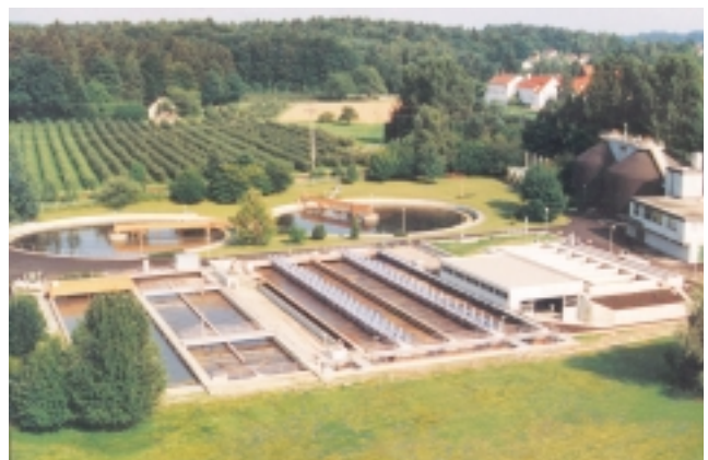
Abb. 1: Kläranlage des Abwasserverbandes Unteres Schusental in Eriskirch-Gmünd (Abwassertechnische Bemessungswerte: Ausbaugröße 30.000 Einwohnergleichwerte, tägliche Wassermenge 3.376 m 3 /d, Schmutzfracht 1.953 kg BSB 5 /d) [Quelle: Abwasserzweckverband].
