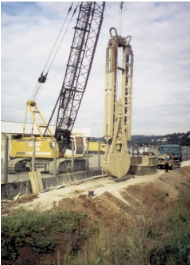
Abb. 3: Einsatz eines Schlitzwandgreifers beim Bau der Dichtwand („Funnel“) [Standort: Ehemalige Fabrik BEKA, Tübingen].
