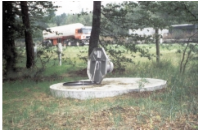
Abb. 3: Messschacht der Bodenmessstation Forst an der Autobahn A5.
