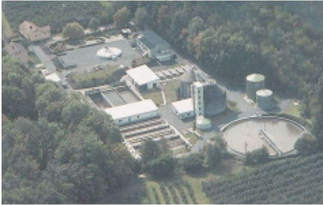
Abb. 2: Kläranlage des Zweckverbandes Abwasserreinigung Kressbronn-Langenargen (Abwassertechnische Bemessungswerte: Ausbaugröße 50.000 Einwohnergleichwerte, tägliche Wassermenge 11.880 m 3 /d, Schmutzfracht 2.170 kg BSB 5 /d) [Quelle: Zweckverband].
