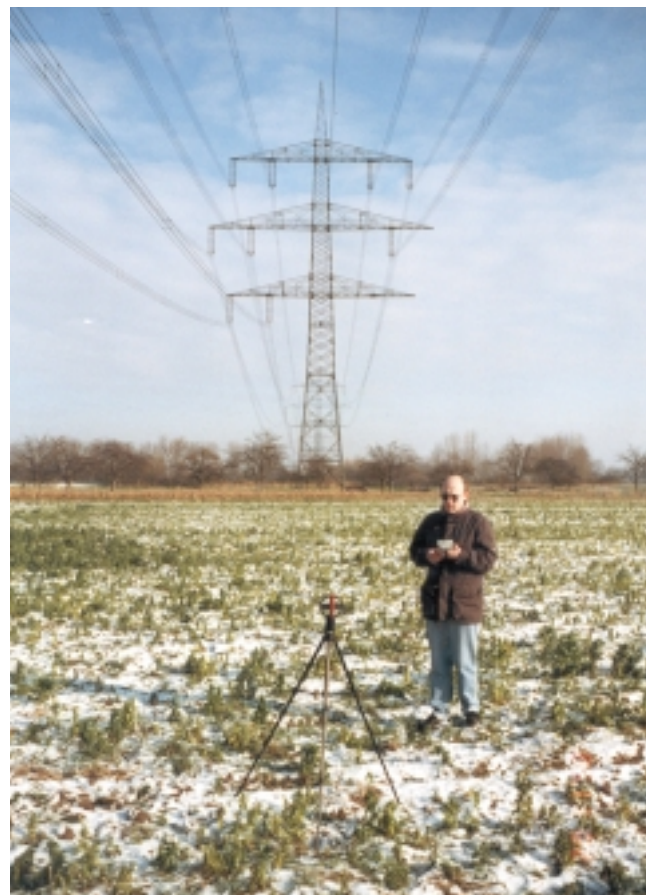
Abb. 1: Feldmessung unter einer Hochspannungsleitung. Die Feldsonde befindet sich auf einem elektrisch isolierten Stativ, da leitende Objekte zu einer Verzerrung der Feldlinien führen können.
