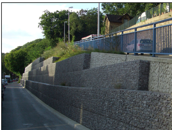
Abb. 49: Vor kurzem errichtete bewuchsfreie Gabionenwand in Dahlhausen (2008, A. JAGEL).
