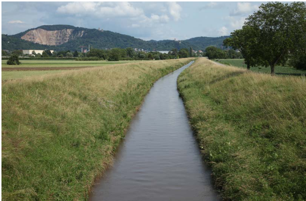
Abbildung 6.10: An stark ausgebauten Fließgewässern fehlen die für eine artenreiche Ufervegetation wichtigen Strukturen wie Sand- und Kiesbänke. Foto: Siegfried Demuth
