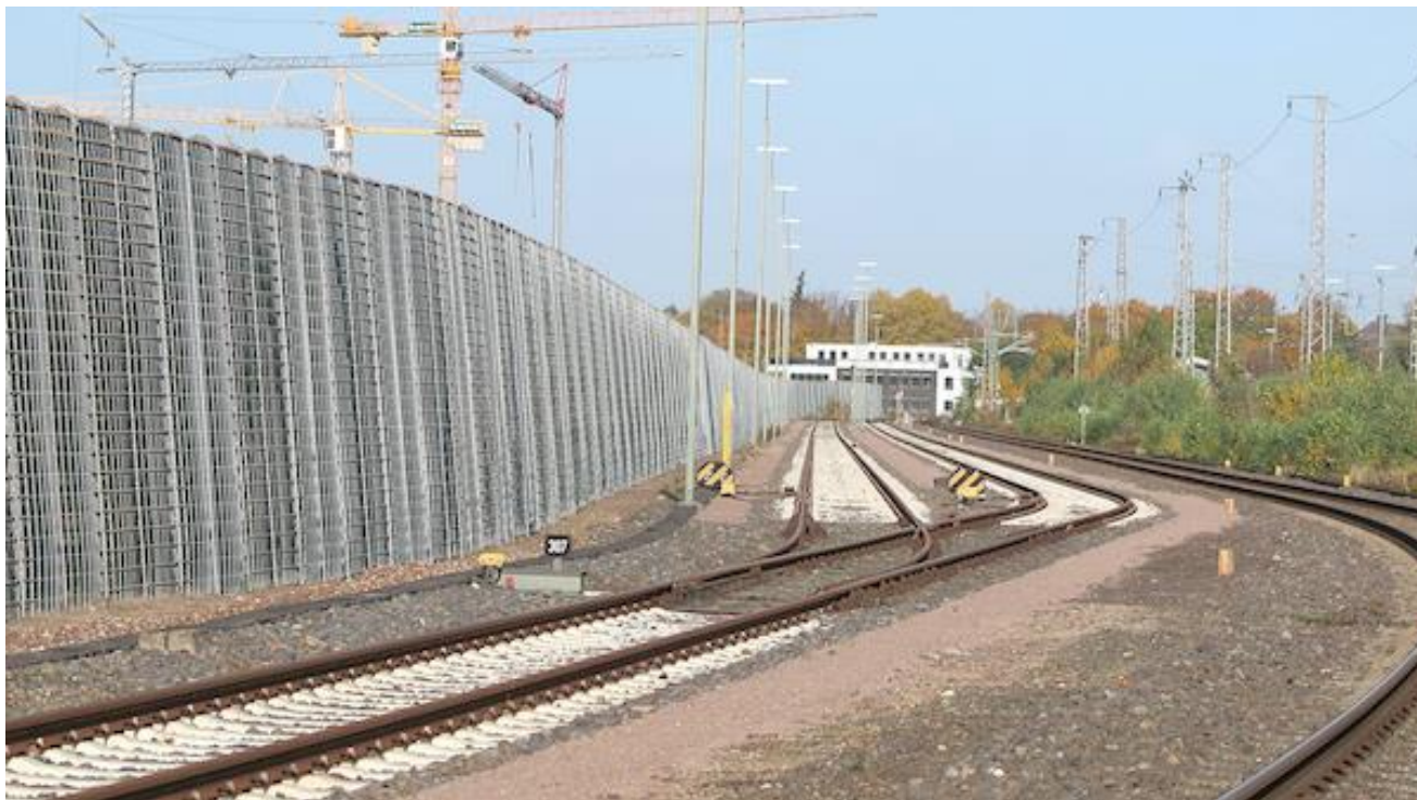
Foto exemplu panouri fonoabsorbant tip „verde”(structura din oțel, apoi aplicare ecologizare)
