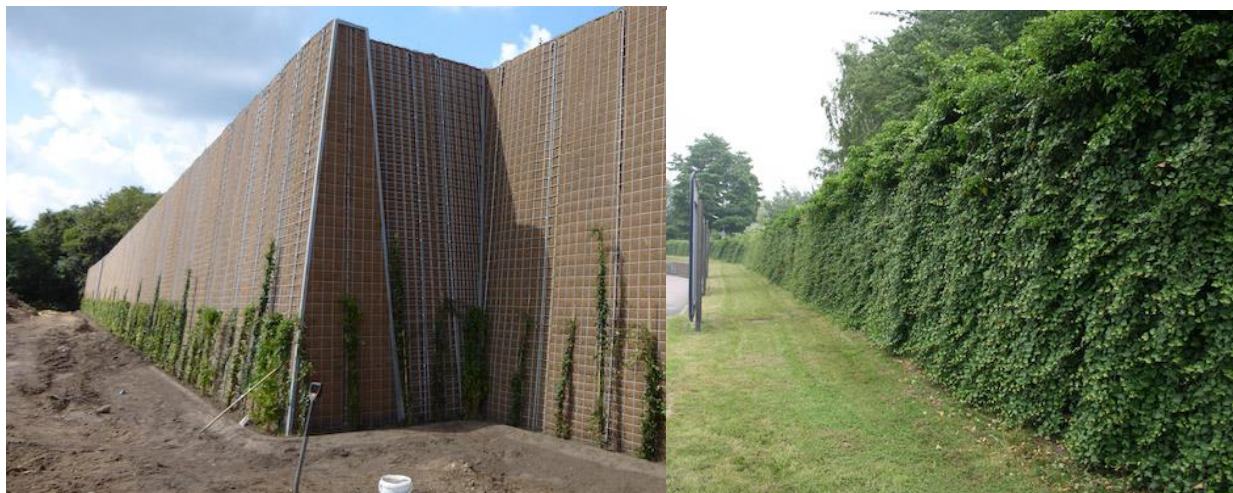
Foto exemplu panouri fonoabsorbant tip „verde”(structura din oțel, apoi aplicare ecologizare)
