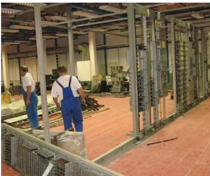
AR gépterem acélszerkezetének építése, elől egy keretsor van
