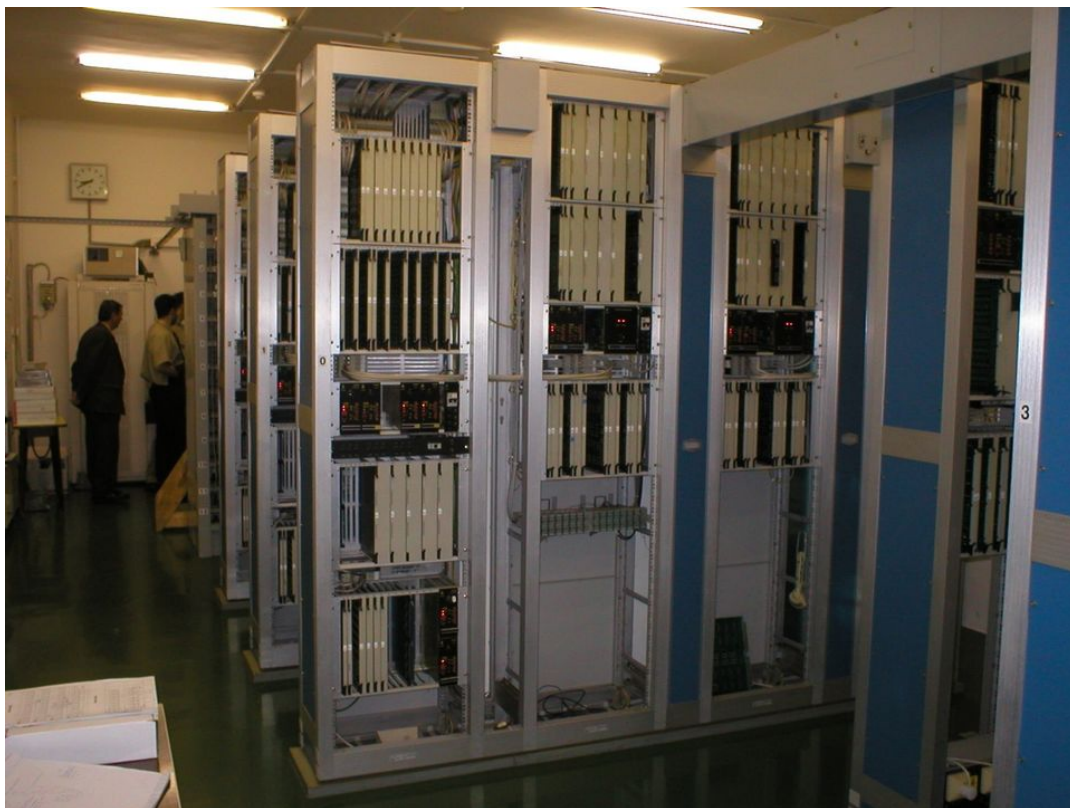
1600 mellékállomással telepített alközpont az MH Központi Katonai kórházban 1992. [4]
